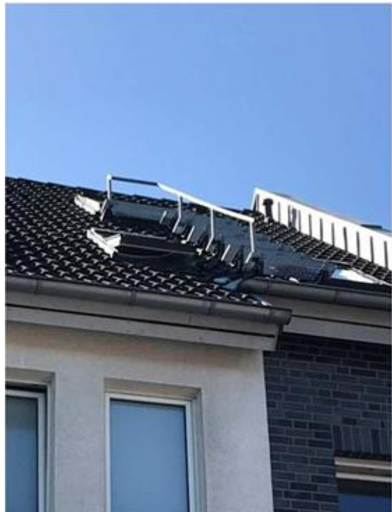
Abbildung 11 Austritt mit mehr als zwei Stufen und Festhaltenmöglichkeit
