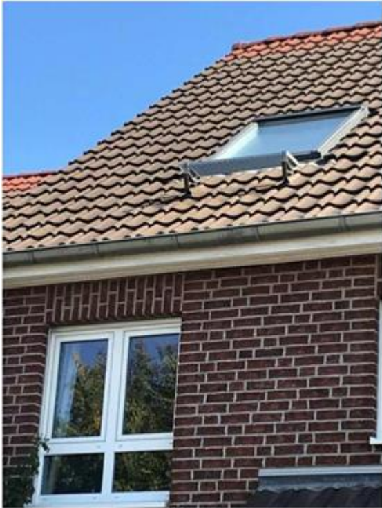
Abbildung 8 Austritt mit einer Stufe
