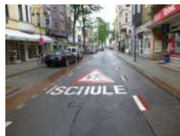
Abbildung 92: Fahrbahnmarkierung im Schulbereich
