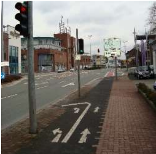
Abbildung 42: Fahrradschleuse im Vorfeld eines großen Knotenpunkts
