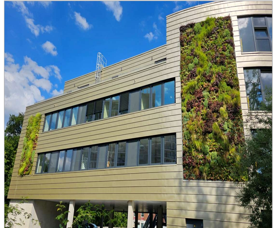
Fassadenbegrünung am Klinikum Leverkusen
