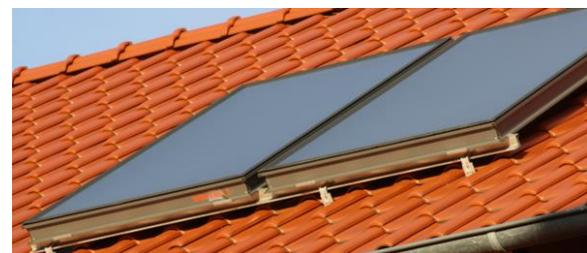
Bei zwei von fünf zzt. installierten thermischen Solaranlagen handelt es sich um so genannte **solarthermische Kombianlagen**, die zusätzlich die Raumheizung unterstützen. Die Kollektorfläche und der Speicher einer Kombianlage sind mit typischerweise 10 - 15 Quadratmeter bzw. etwa 500 - 1000 Liter Inhalt größer ausgelegt. Eine
