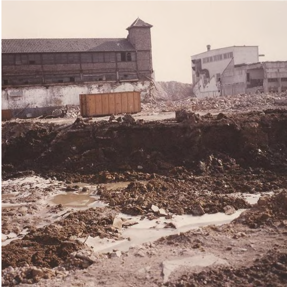
Abb. 101: Aufgrund der Bodenverunreinigungen mussten Teile des Bodens auf dem Gelände der Schusterinsel ausgetauscht werden.
