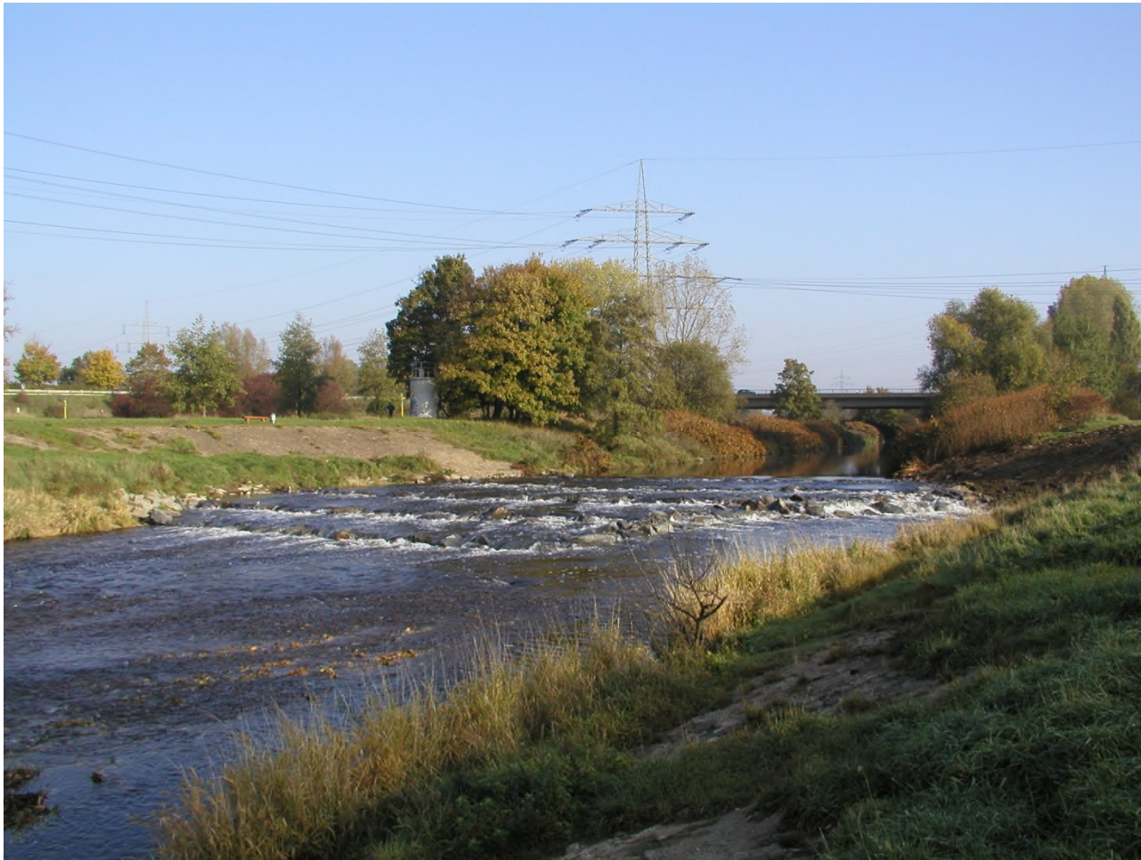
Abb. 53: Die neue Fischrampe am Tonnenwehr am 28.10.2003
