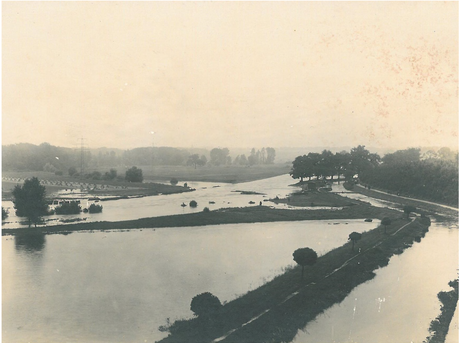
Abb. 26: Das Wupperhochwasser vom August 1924 vom Reuschenberger Schloss aus gesehen, rechts der Mühlengraben Foto: Stadtarchiv Leverkusen
