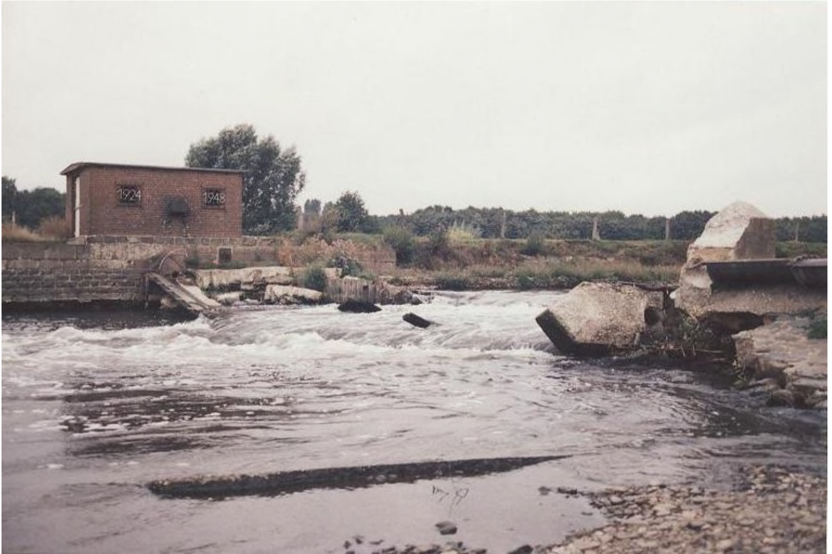
Abb. 84: Die beim Januarhochwasser 1995 zerstörte rechte Wehrseite des Reuschenberger Wehres im September 1995
