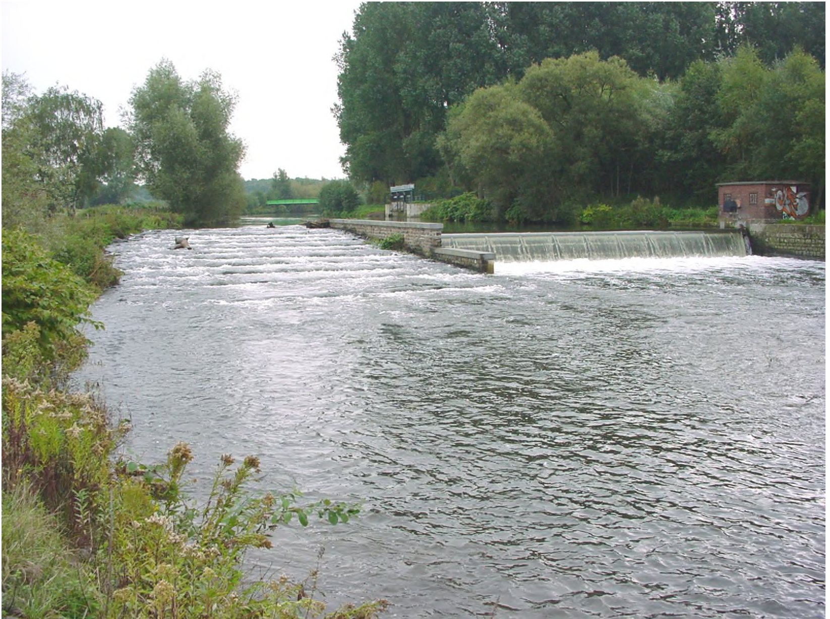
Abb. 93: Das Bild zeigt das neue Reuschenberger Wehr und die Fischrampe am 05.10.2001. In dem Häuschen auf der linken Wehrseite ist die Steuerung der Wehrklappe untergebracht.
