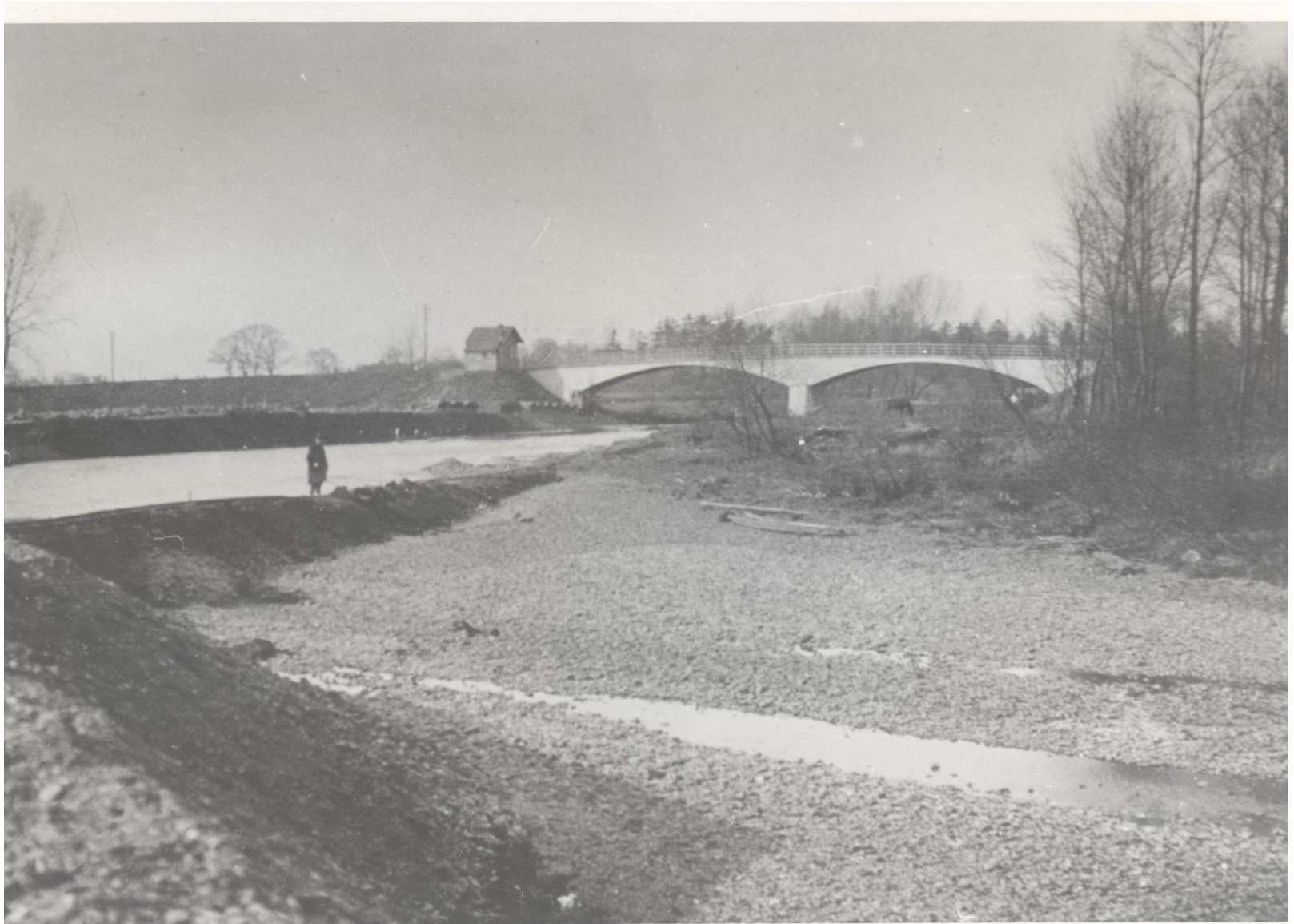
Abb. 123: Die Regulierungsarbeiten der Wupper stehen kurz vor dem Ende. Auf dem Foto ist die Hebestelle für das für die Benutzung der Brücke zu zahlende Brückengeld auf der Rheindorfer Brückenseite zu erkennen. 1911 Foto: Deichverband Leverkusen
