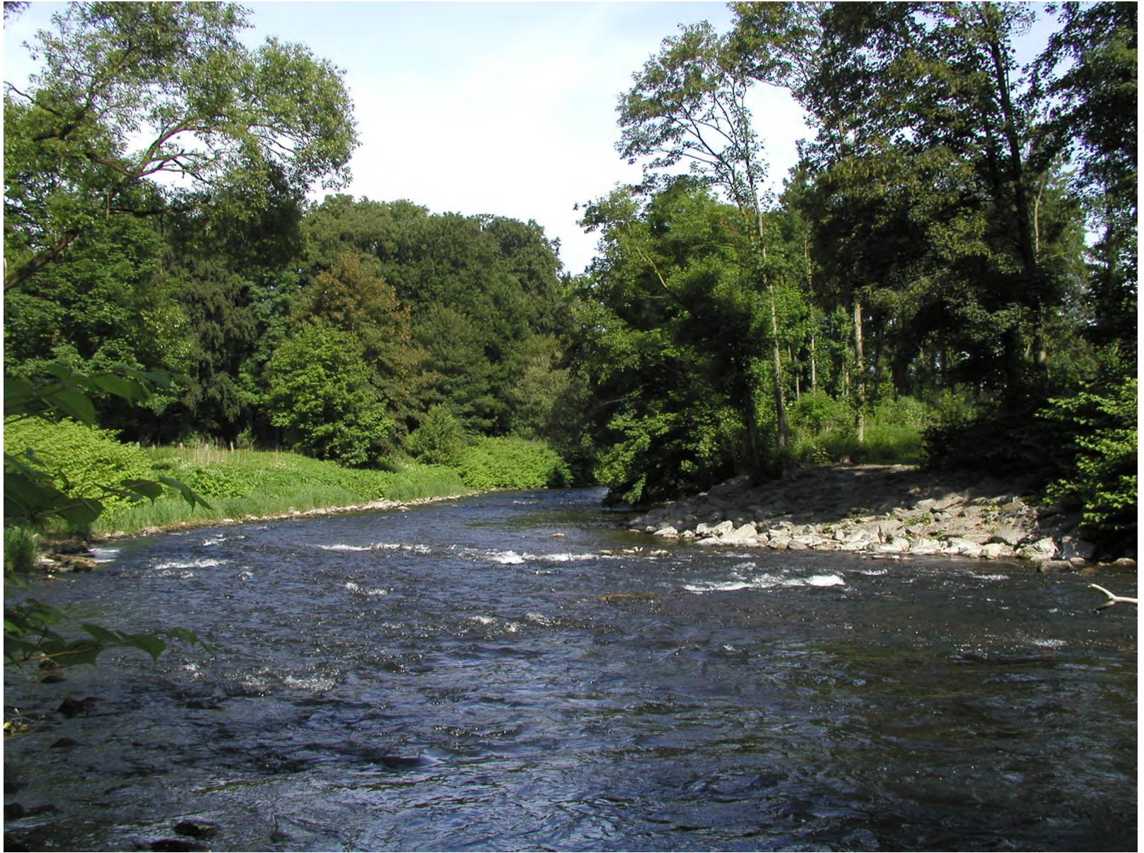
Abb. 21: Dieser Blick von der Fußgängerbrücke unter der Brücke der Bahnstrecke Köln-Wuppertal (siehe Abb. 3) wupperabwärts ergab sich am 19.05.2009. Am rechten Leichlinger Wupperufer hat der Wupperband einen Uferabbruch mit einer neuen Steinschüttung ausgebessert.
