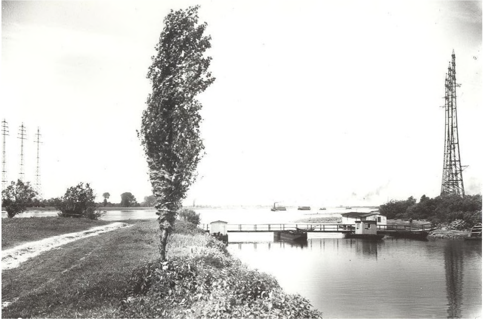
Abb. 121: 1929 wurde die Steganlage in der Wuppermündung durch diese robustere Konstruktion ersetzt. Ca. 1935 Foto: Stadtarchiv Leverkusen
