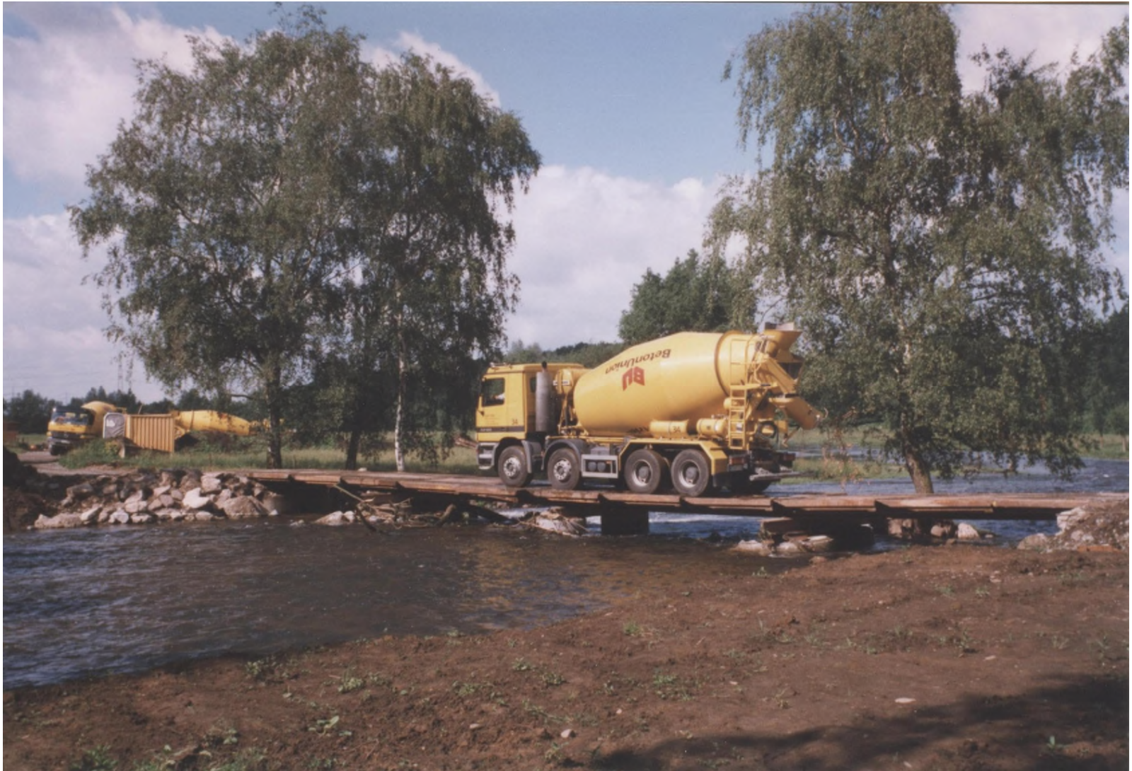
Abb. 90: Die Behelfsbrücke über den geöffneten Damm zwischen dem Wupperbett und dem Flutgraben wurde während der Bauarbeiten am Reuschenberger Wehr schwer belastet. 08.06.1999
