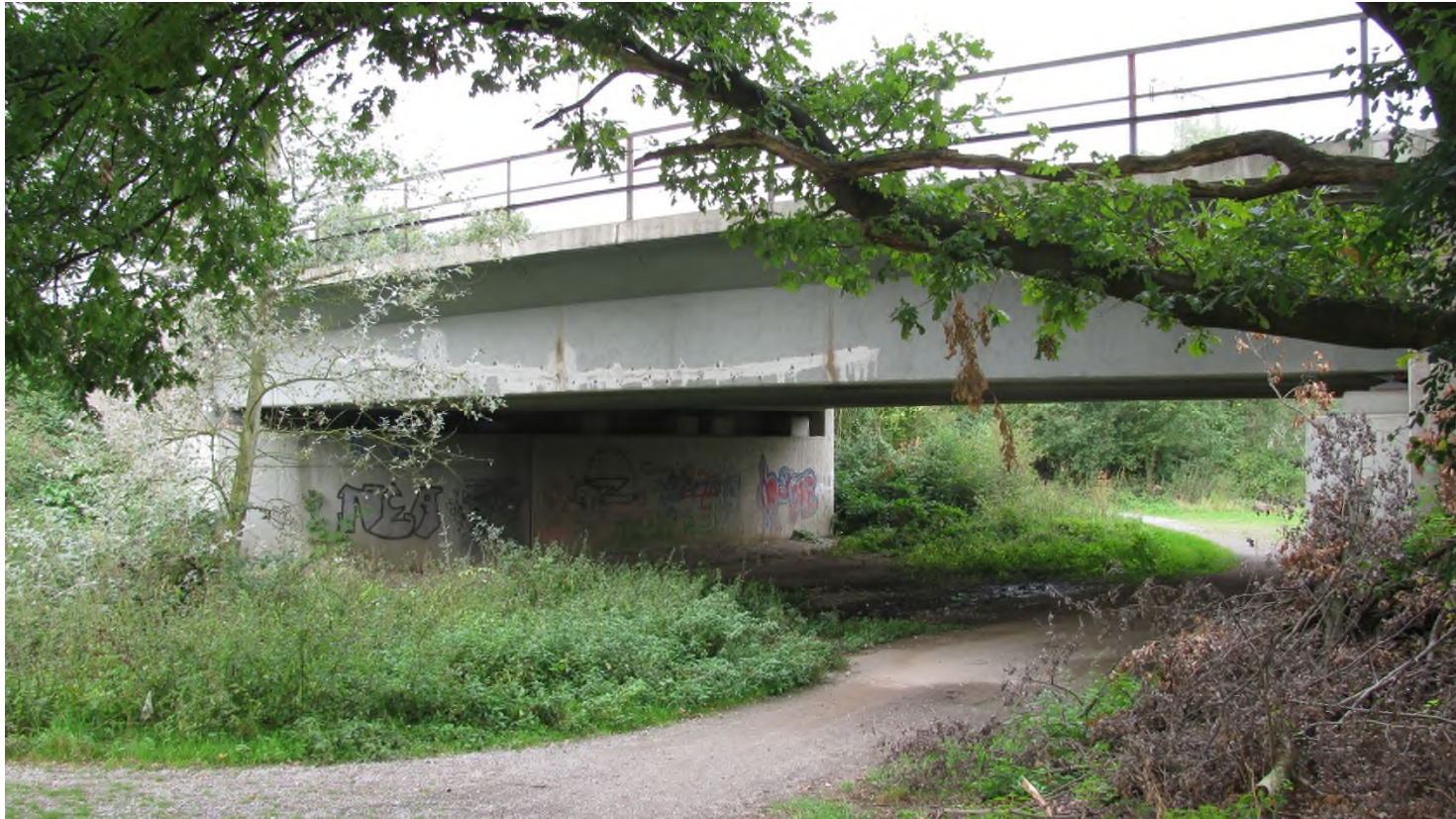
Abb. 60: Die Flutbrücke befindet sich direkt nordwestlich der Wupperbrücke der Eisenbahnstrecke Köln-Düsseldorf. Neben der Aufnahme eines Feldweges ist ihre Hauptaufgabe Wupperhochwässer abfließen zu lassen. 16.09.2009
