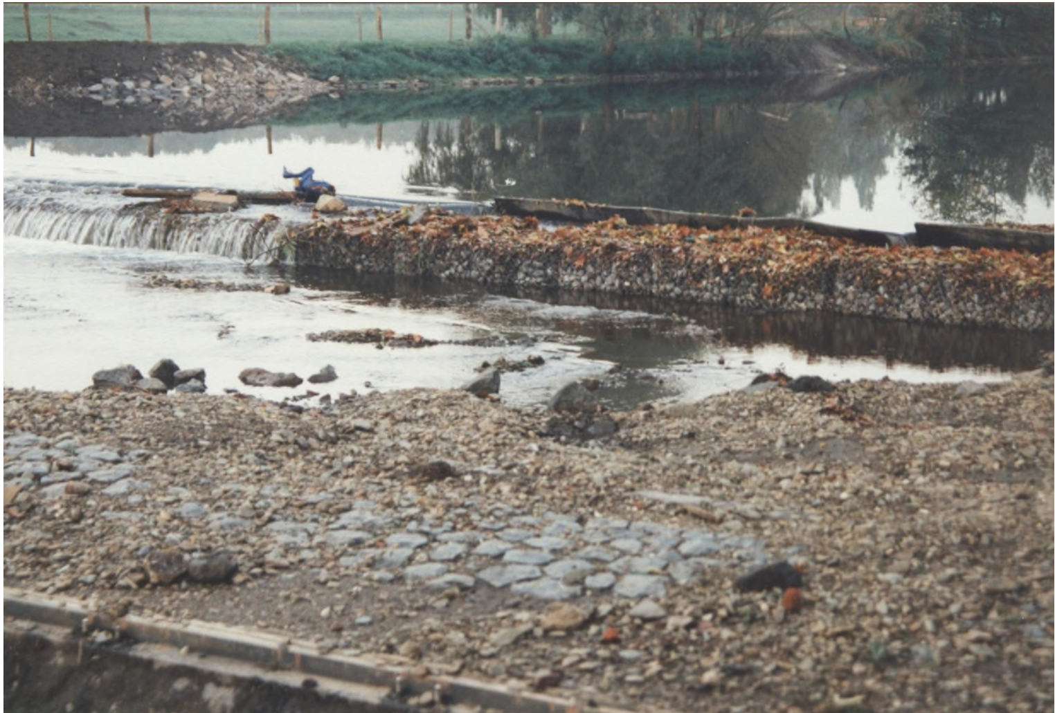
Abb. 87: Zu erkennen sind die Gabionen und das Förderband aus Gummi des provisorischen Reuschenberger Wehres. Das „Gummiband“ war ständig irgendwo umgeknickt. Daher verblieb immer Wasser in der Wupper. 02.11.1995
