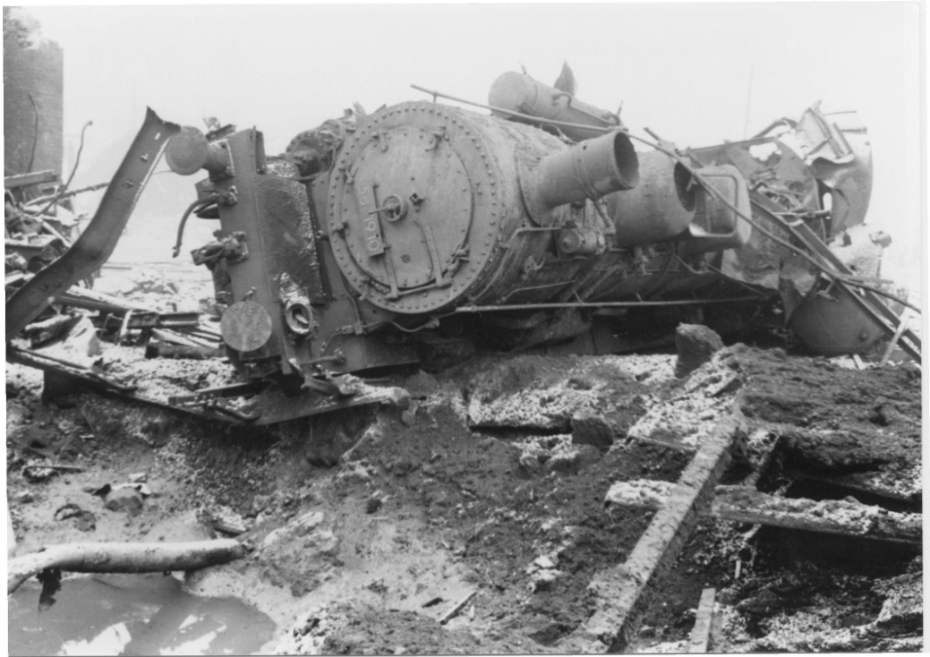
Abb. 31: Etwa 13 Monate vor dem Unglück bei dem Wupperhochwasser war 38 1910 am 28.12.1944 im Bf Opladen bei einem Luftangriff getroffen und ebenfalls stark beschädigt worden.
