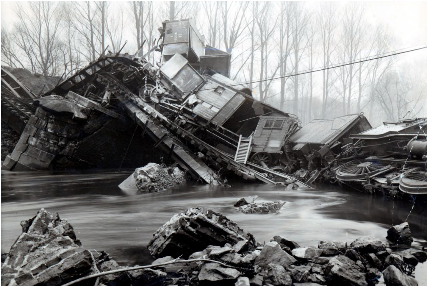
Abb. 28: Am 09.02.1946 brach bei einem Wupperhochwasser die Behelfsbrücke der Bahnstrecke Opladen - Hilden unter einem Güterzug zusammen.
