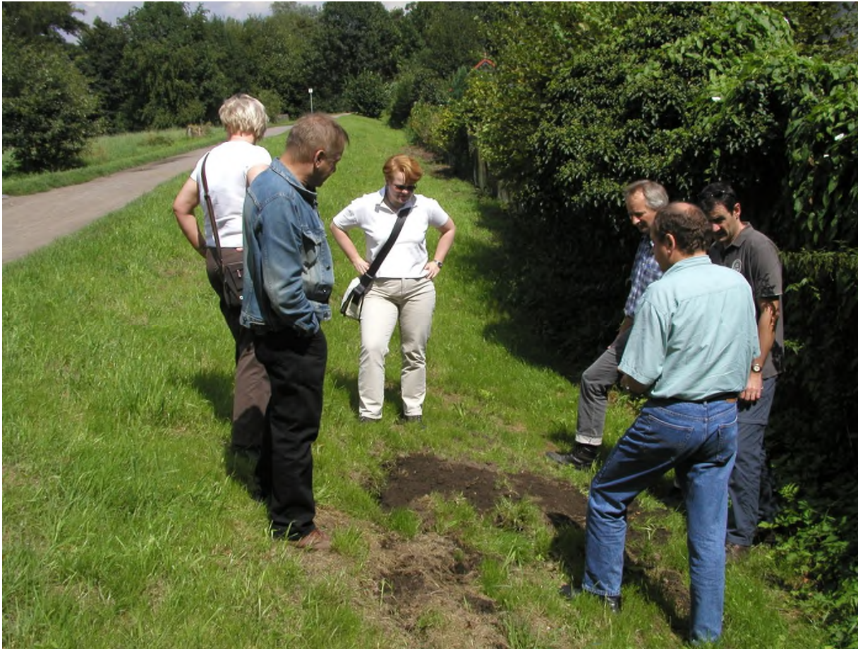
Abb. 62: Bei der Deichschau der Unteren Wasserbehörde am 13.08.2007 werden Wühltierschäden aufgenommen.
