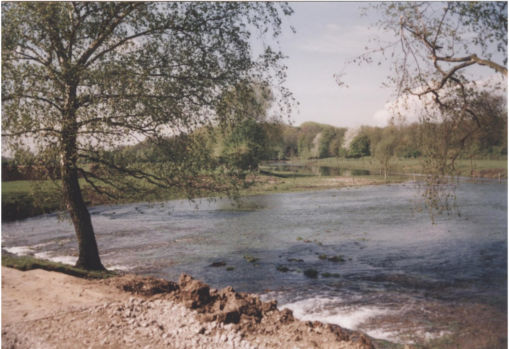
Abb. 88: Während der Arbeiten am Reuschenberger Wehr und der Fischrampe wurde die Wupper oberhalb des Wehres in den Flutgraben (siehe Abb. 58 und 59) umgeleitet. Dazu wurde der Damm (im Vordergrund) zwischen Wupper und dem Flutgraben geöffnet. 23.04.1999
