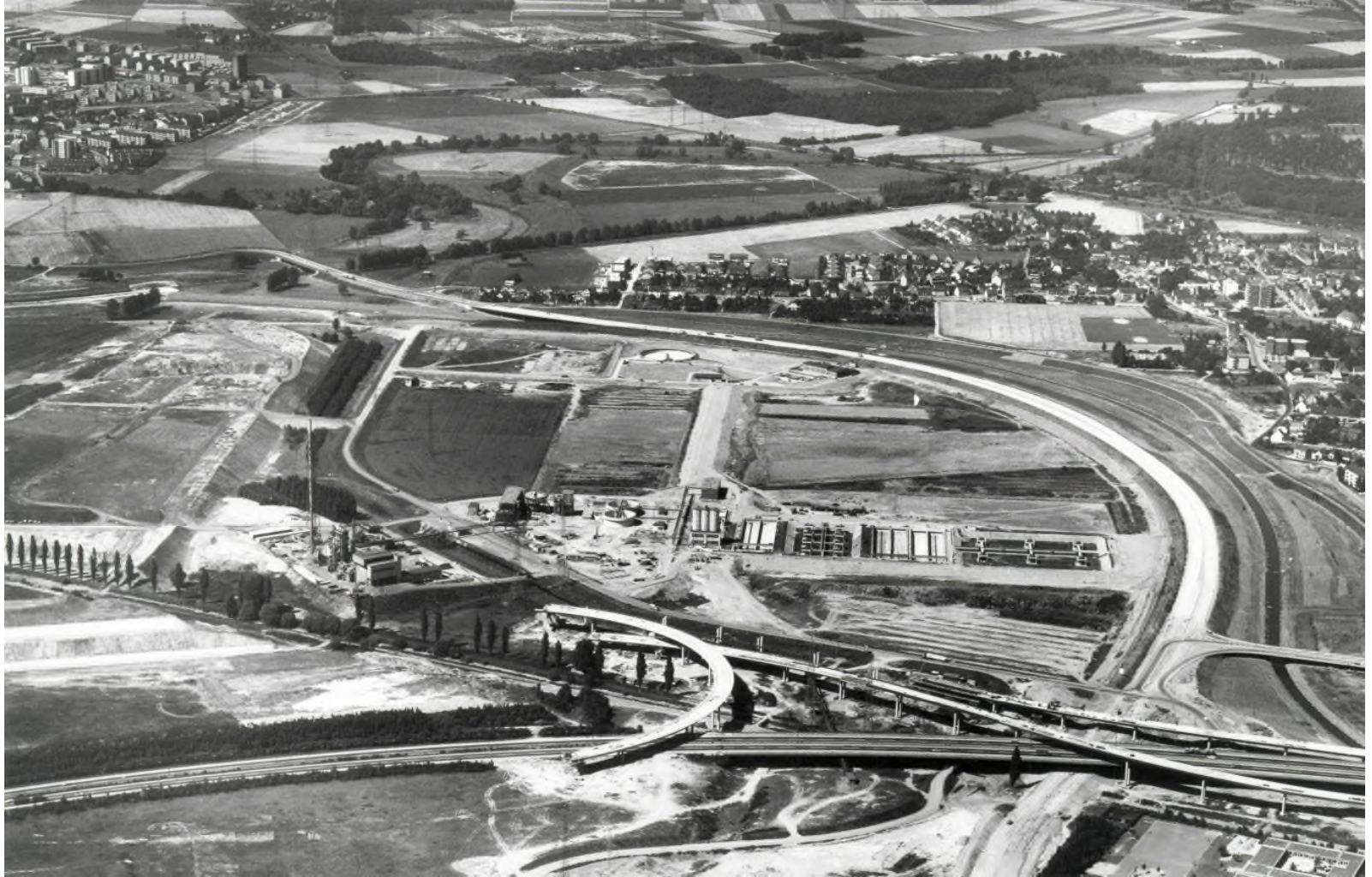
Abb. 49: Auf dieser Luftaufnahme von 1971 ist das neu errichtete Entsorgungszentrum der Bayer AG enthalten. Dhünn und Wupper fließen bereits in ihren neuen Gewässerbetten. Auf dem alten Bürriger Deich verläuft die Werksstrasse des Entsorgungszentrums.
