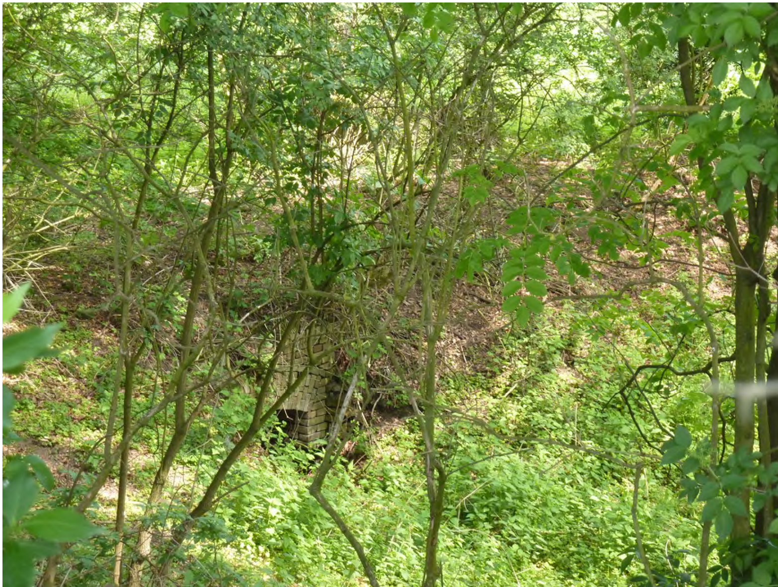
Abb. 118: Innerhalb des Dammes des nördlichen Teichs (siehe Abb. 71) des Wambacher Hofes befindet sich dieses Bauwerk, in dem vermutlich der Zulauf aus der Wupper abgeschiebert werden konnte. 21.05.2010
