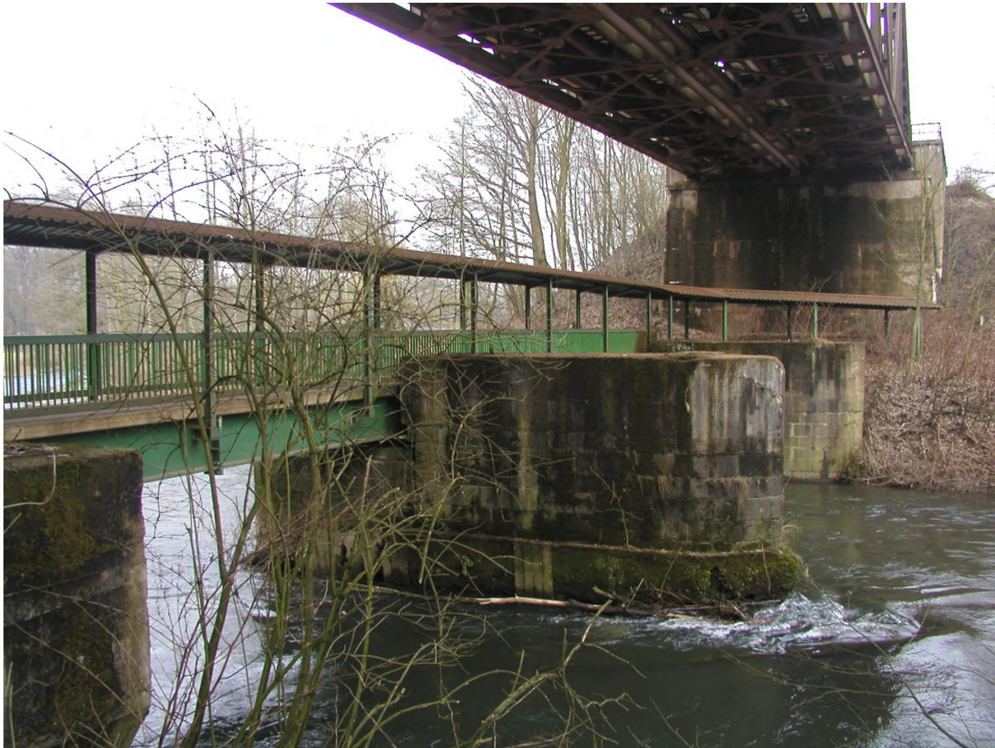
Abb. 3: oben - Wupperbrücke der Eisenbahnstrecke Köln-Wuppertal, unten – Die Fußgängerbrücke auf den Pfeilern, der im 2. Weltkrieg zerstörten alten Bahnbrücke, wurde wegen den früher nicht geschlossenen Toilettensystemen überdacht. Auf den erhöhten Bereichen der alten Brückenpfeiler standen die Stützen der nach dem Krieg errichteten Behelfsbrücke (siehe auch Abb. 29). Februar 2009 Foto: Günter Schmidt
