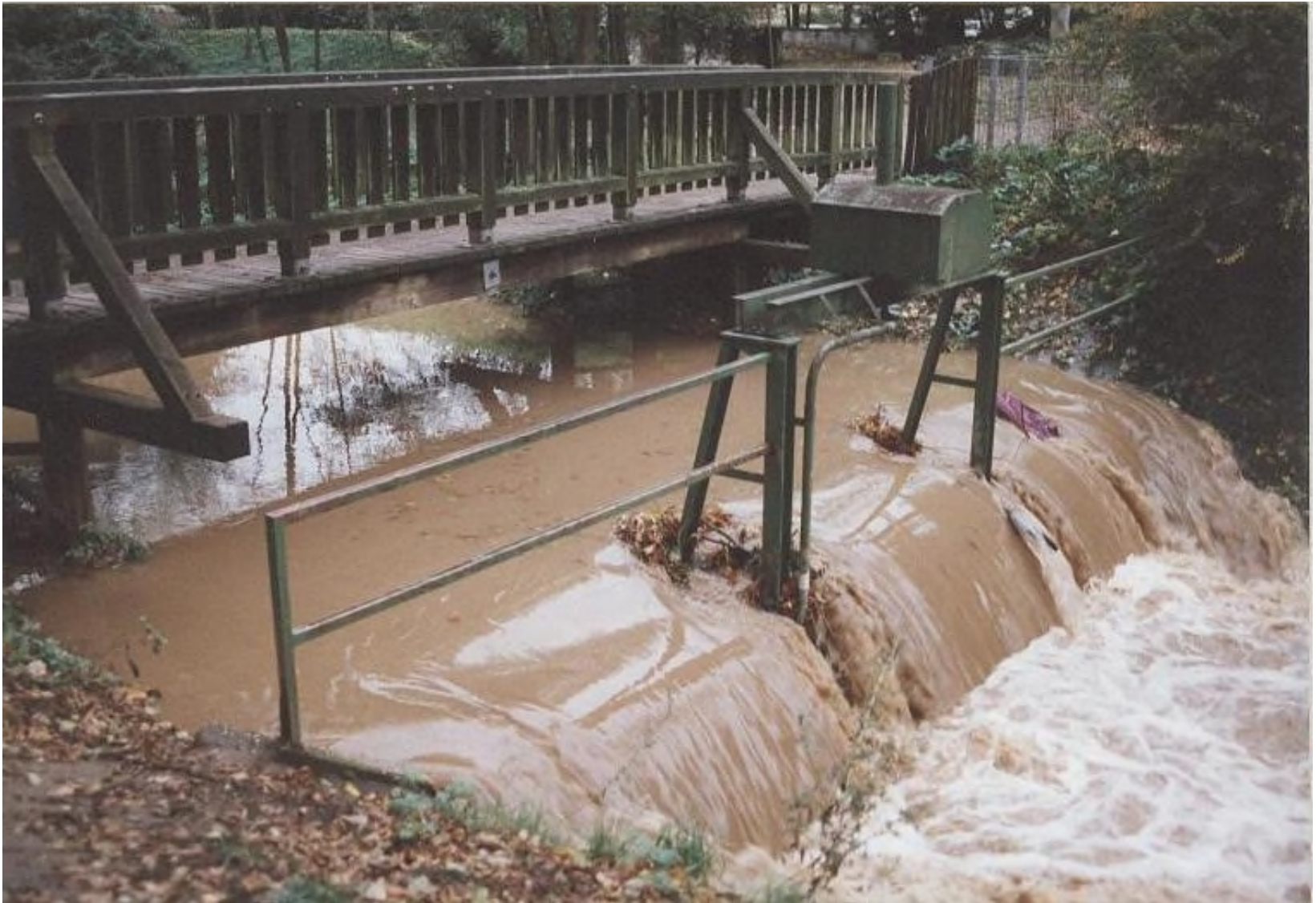
Abb. 8: Bis 2000 wurde der Wiembach durch ein Wehr angestaut, um die Rehbockanlage mit Wasser zu versorgen. 19.10.1998
