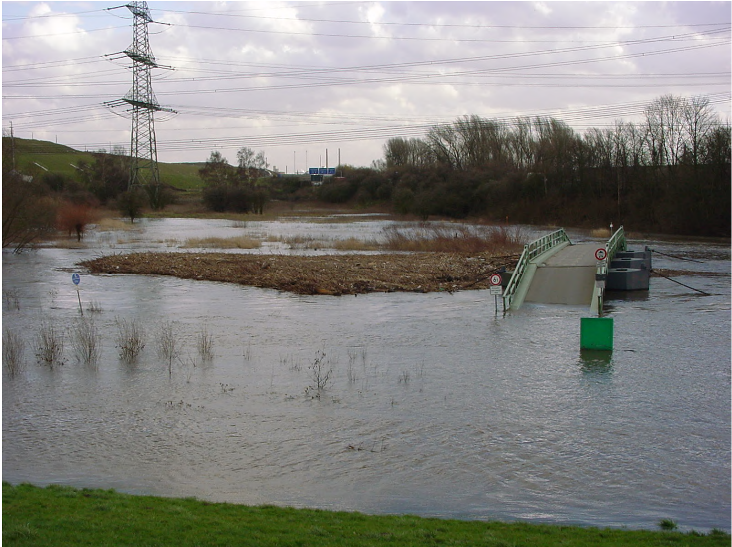
Abb. 34: An der Pontonbrücke sammelt sich bei Hochwasser Treibgut, wodurch die Wupperbrücke oberstromig nach unten gedrückt wird. 26.02.2002
