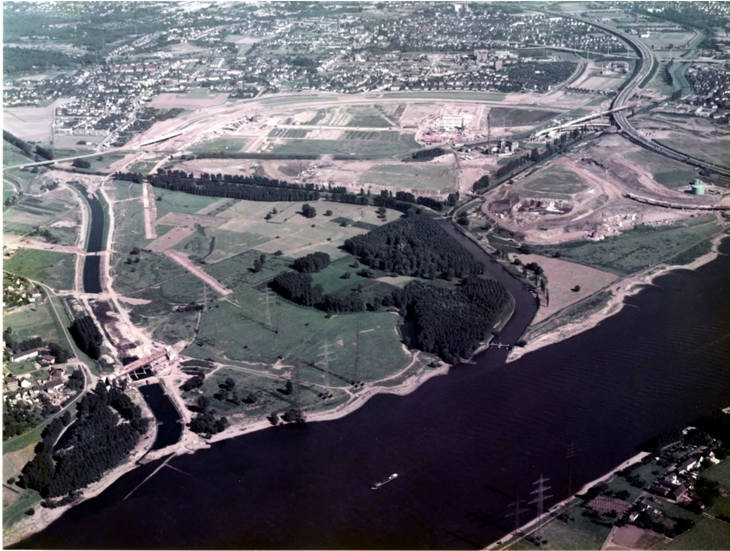
Abb. 50: Auf dieser Aufnahme von 1970 fließen Dhünn und Wupper noch in Ihren alten Betten. Das neue Wupperbett ist fast vollständig fertig gestellt. Im Bau befindet sich auch die Autobahnbrücke der A 59 über die neue Wuppermündung, das Autobahnkreuz Leverkusen-West und das Gemeinschaftsklärwerk. Die alte Dhünnmündung und die Wupper kreuzt noch die Rohrbrücke der Ruhrgas AG.
