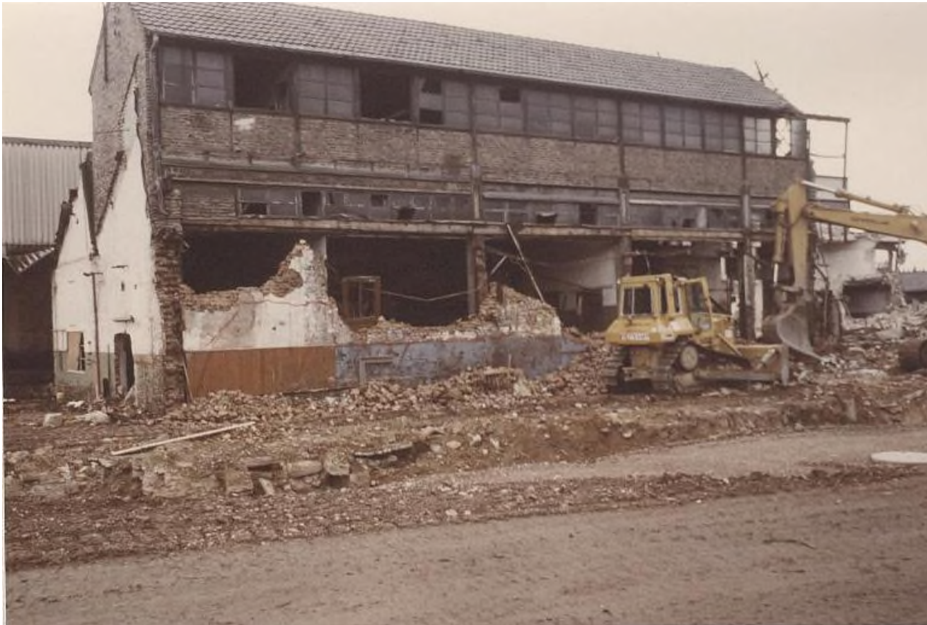
Abb. 100: 1987 wurden die Gebäude der Schusterinsel abgebrochen, wie hier die alte Säureabfüllung
