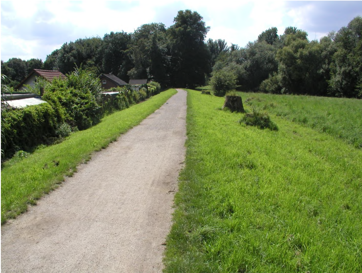
Abb. 63: Deich zwischen der Elsbachstrasse und der Brücke zur Himmelsleiter am 13.08.2007
