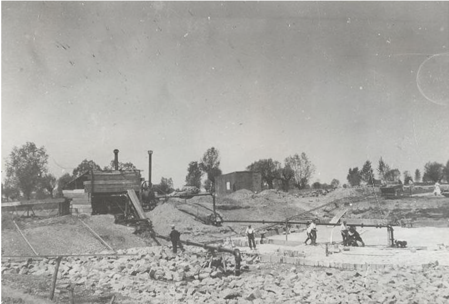
Abb. 44: Während der Regulierungsarbeiten wurde die Baustelle für das neue Wupperbett von einer von einer Dampfmaschine angetriebenen Pumpe trocken gehalten.
