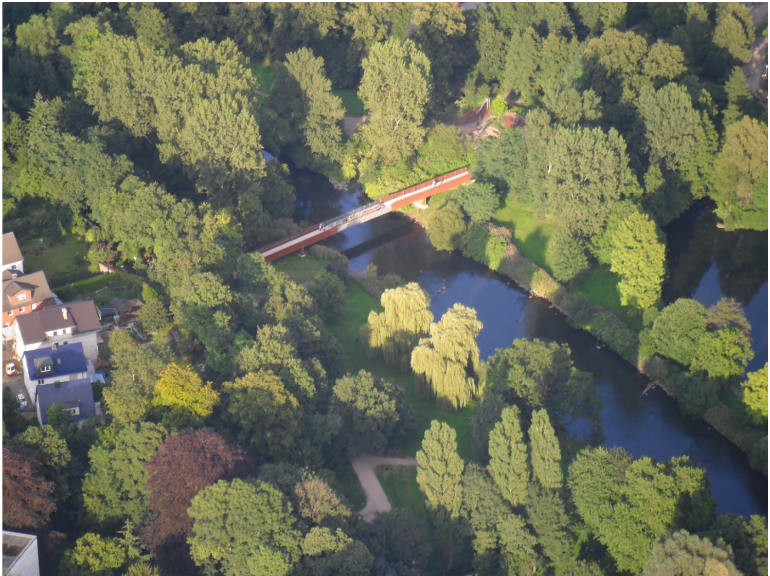
Abb. 9 Neu errichtete Fußgängerbrücke zur Treppe Himmelsleiter in Opladen am 11.08.2012
