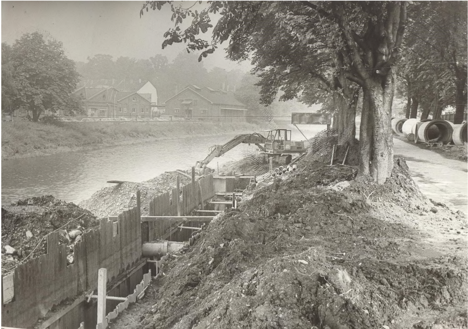
Abb. 126: Dieses Foto zeigt die Verlegung des Wuppersammlers entlang der Schusterinsel in Opladen Ende der 1960er Jahre. Oberhalb des Baggers kann man das Drahtseil des Opladener Pegels und im Hintergrund die Goetze AG erkennen. Links kreuzt eine Abwasserleitung der Schusterinsel in die Wupper den Kanalgraben.
