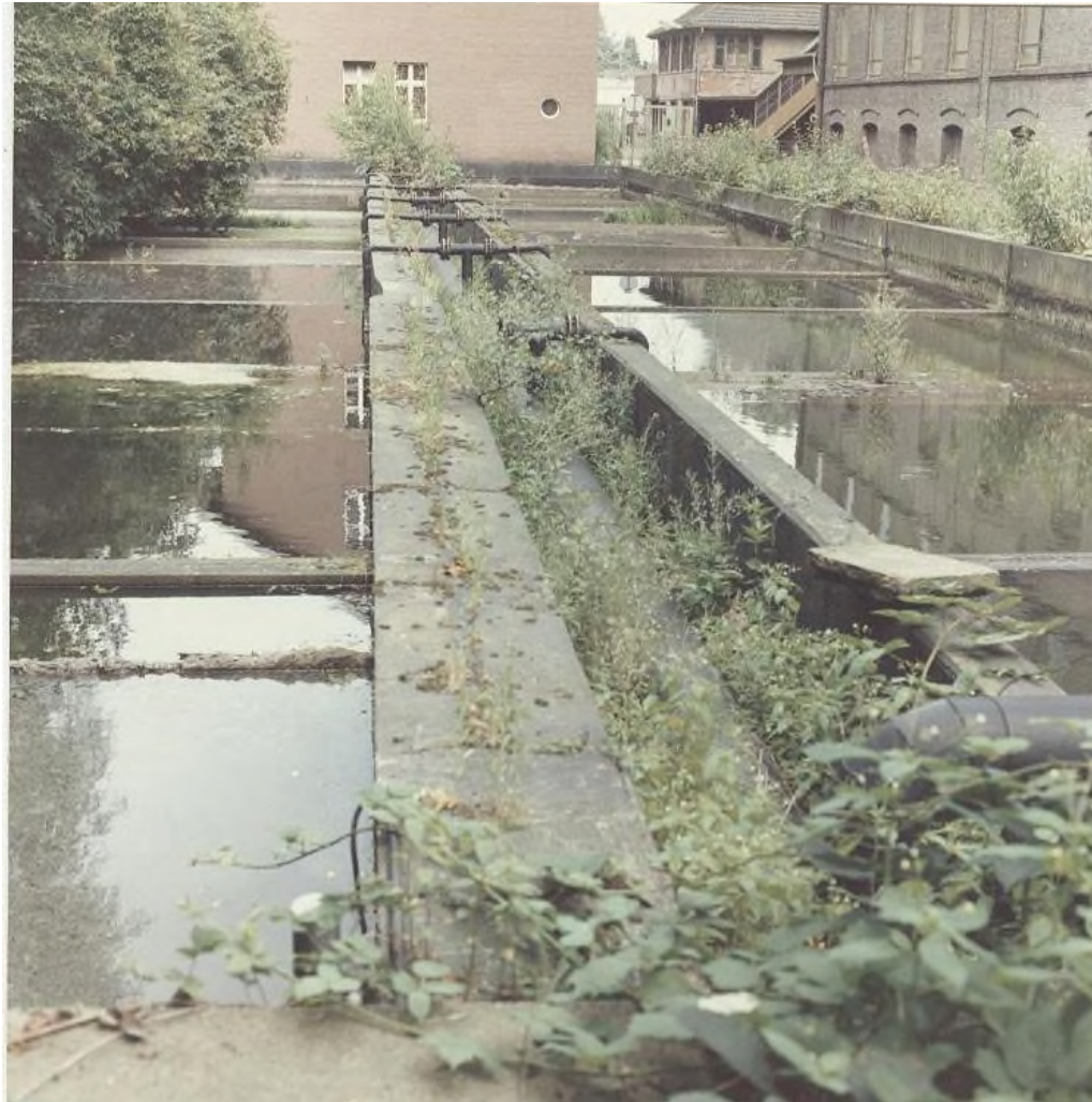
Abb. 104: Die Abwässer der Schusterinsel wurden teilweise über dieses Neutralisationsbecken in die Wupper eingeleitet. 1985
