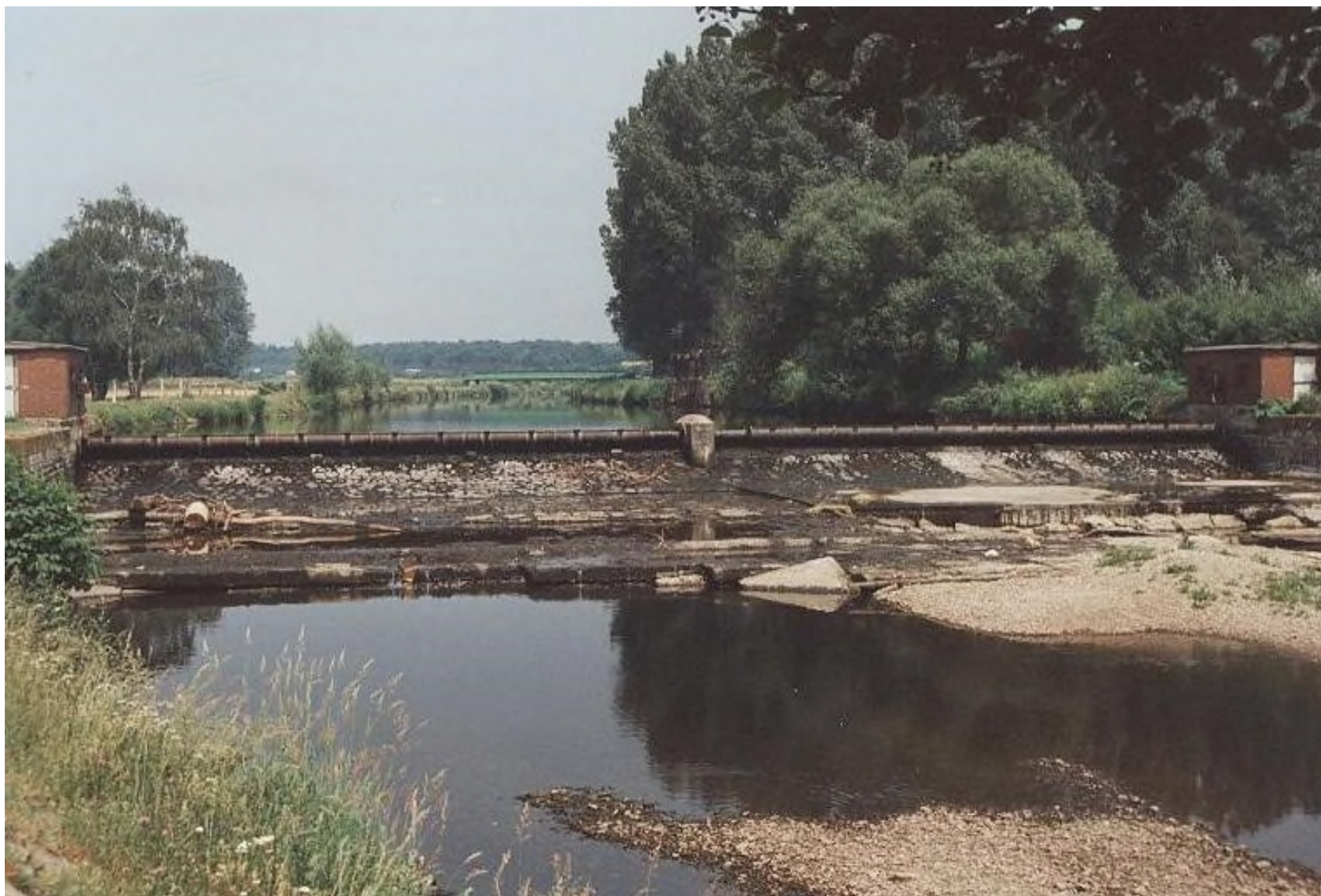
Abb. 81: 1948 wurden auf dem festen Wehrkörper zwei bewegliche Klappen montiert, die bei Hochwasser umgelegt werden mussten. Regelmäßig gelangte wie hier am 08.10.1993 außer durch Undichtigkeiten kein Wasser mehr in das Flussbett unterhalb des Wehres. Die zugesagte Restwassermenge für die Wupper wurde nicht dauernd eingehalten.
