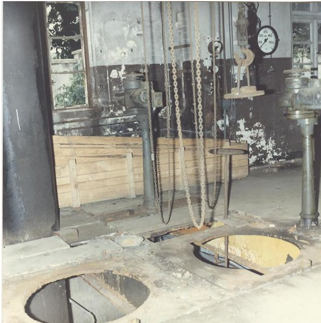
Abb. 103: Wegen der Wupperverschmutzung versorgte sich die Schusterinsel über Brunnen mit Grundwasser. Auf dieser Aufnahme von 1985 ist der Sammelbrunnen 1 zu erkennen.
