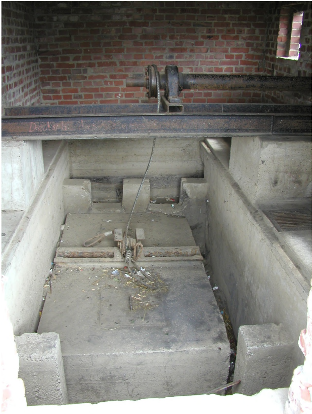
Abb. 82: Jede Wehrklappe wurde durch in einem Häuschen untergebrachten Schwimmer gesteuert. Bei steigendem Wasserspiegel schwammen die Schwimmkörper auf. Das mit der Welle verbundene Drahtseil lockerte sich, und der Wasserdruck der Wupper senkte die Wehrklappen. Im Häuschen auf der rechten Seite der Fischrampe ist diese alte Steuerung erhalten geblieben. 02.07.2003
