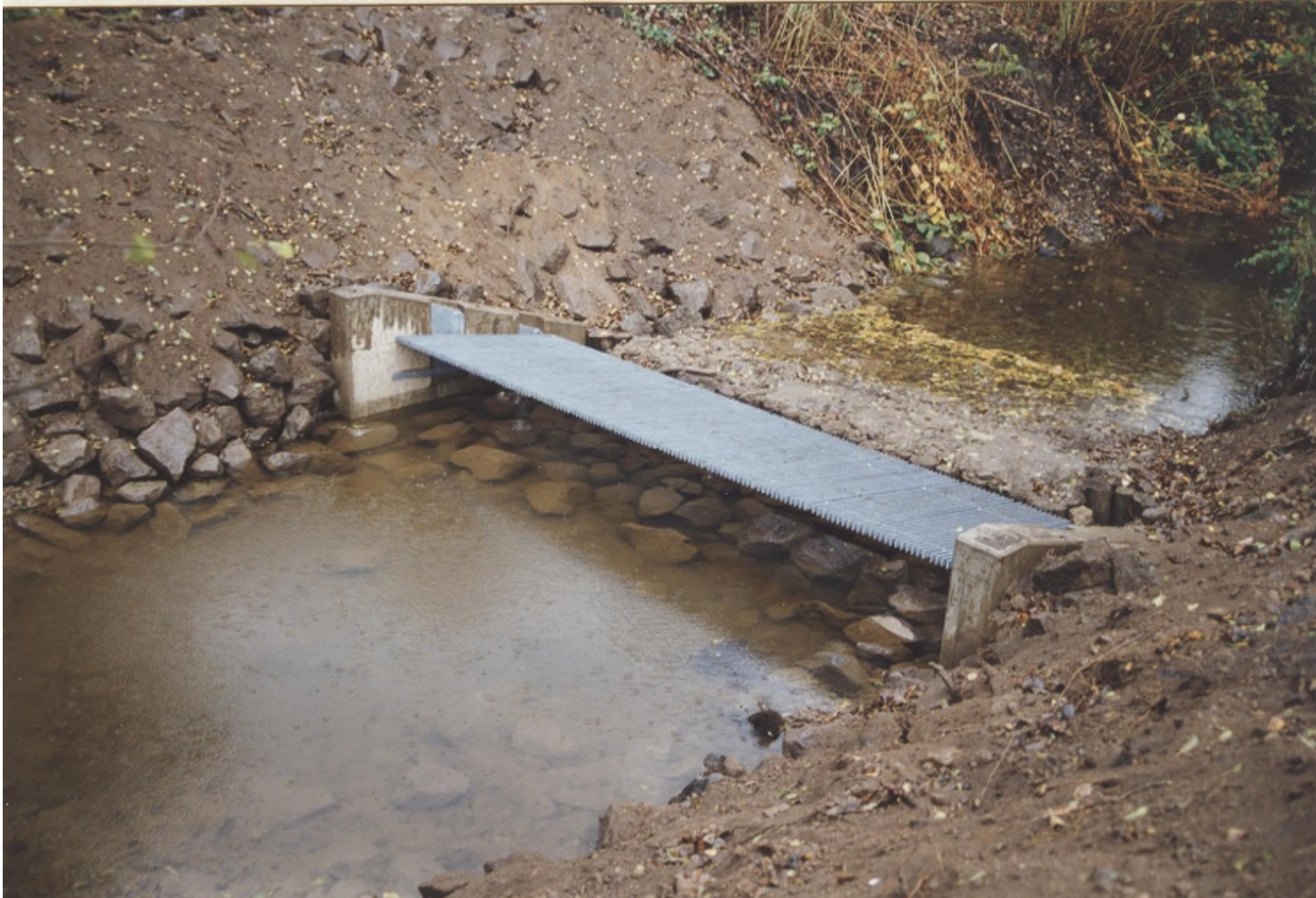
Abb. 86: Dass Fische in den Untergraben der Reuschenberger Mühle einwandern, soll dieser Rechen verhindern. 02.11.1999
