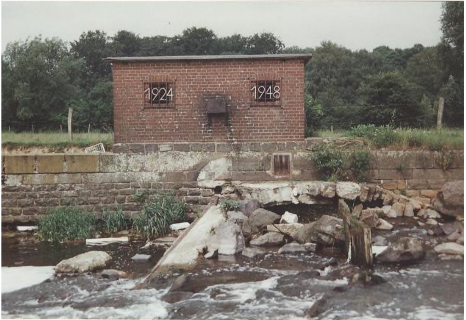
Abb. 83: Zu sehen ist der zerstörte Wehrkörper und das Häuschen mit der erhaltenen alten Wehrklappensteuerung. Unter der Jahreszahl 1948 ist der Wassereinlauf für die Steuerung zu erkennen. 24.06.1998
