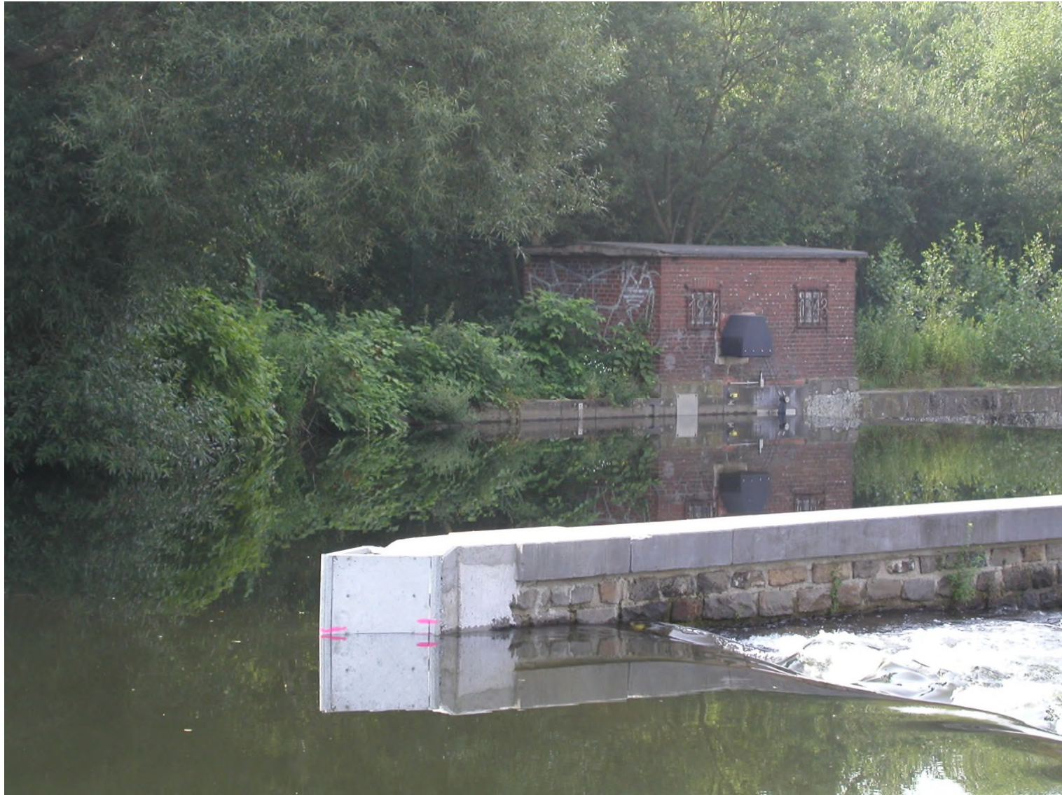
Abb. 95: Der neu angebrachte Abweiser soll solche Schäden künftig verhindern. 08.07.2003
