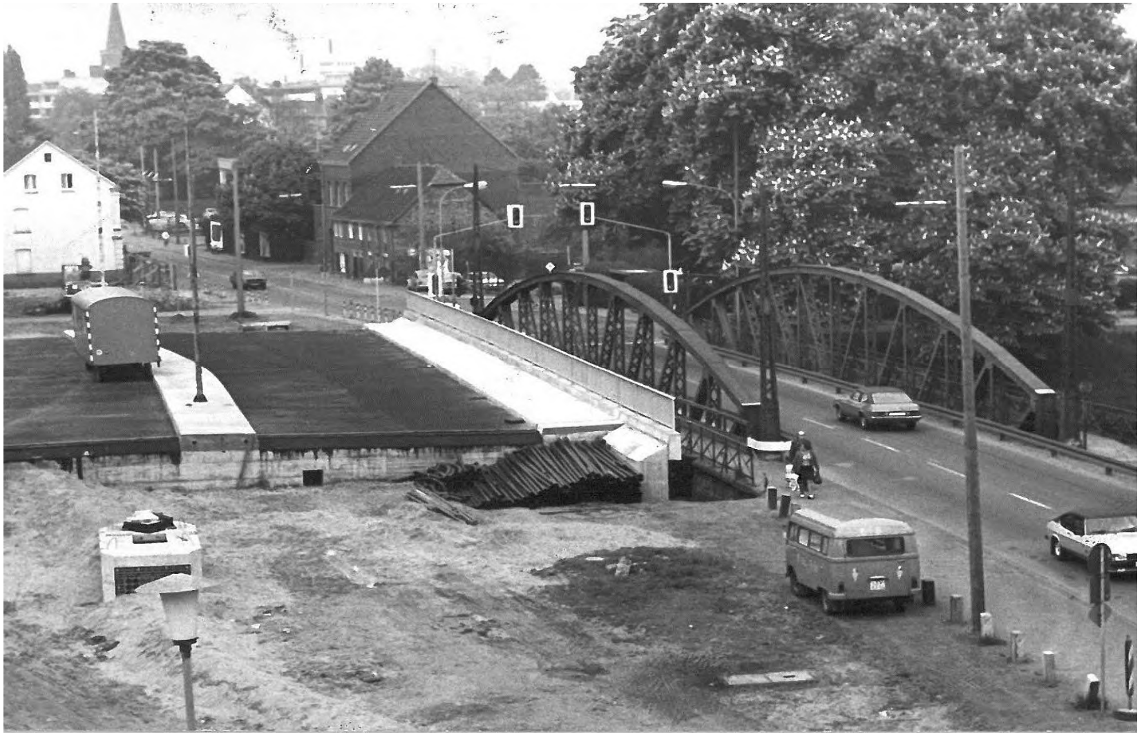
Abb. 143: 1979 wurde die Stahlbogenbrücke durch die aktuelle Stahlbetonkonstruktion ersetzt. Die auf dem Bild noch vorhandene Stahlbogenbrücke wurde 1980 zurückgebaut. Foto: Stadtarchiv Leverkusen
