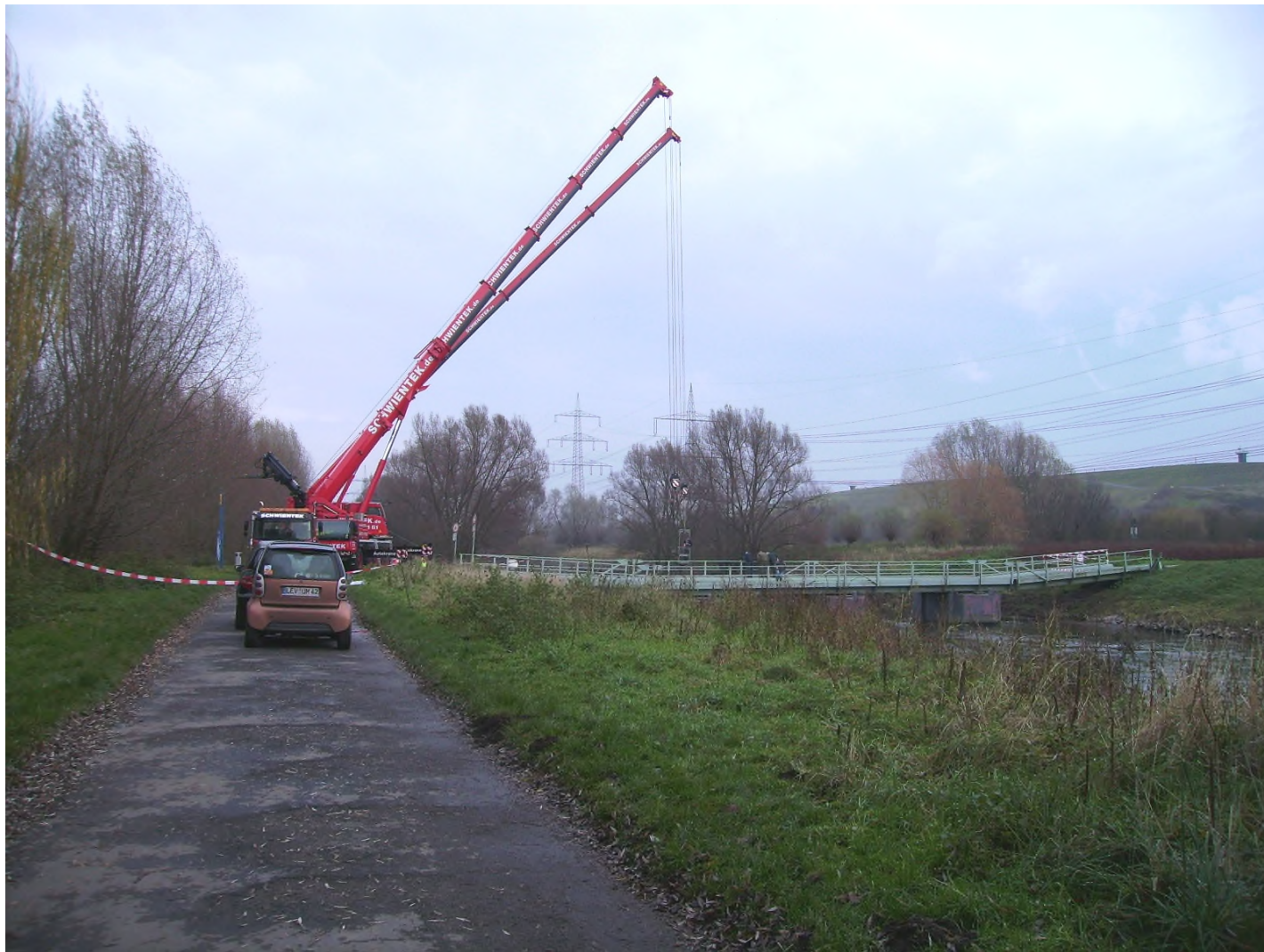
Abb. 38: Während ein Autokran die Brücke anhub, ließ ein 2. Kran einen Korb mit einem Mitarbeiter herab (Bildmitte), der die Stämme mit Drahtseilen vertäute. Anschließend wurden die Stämme mit der Winde eines Bergungsfahrzeugs an Land gezogen.
