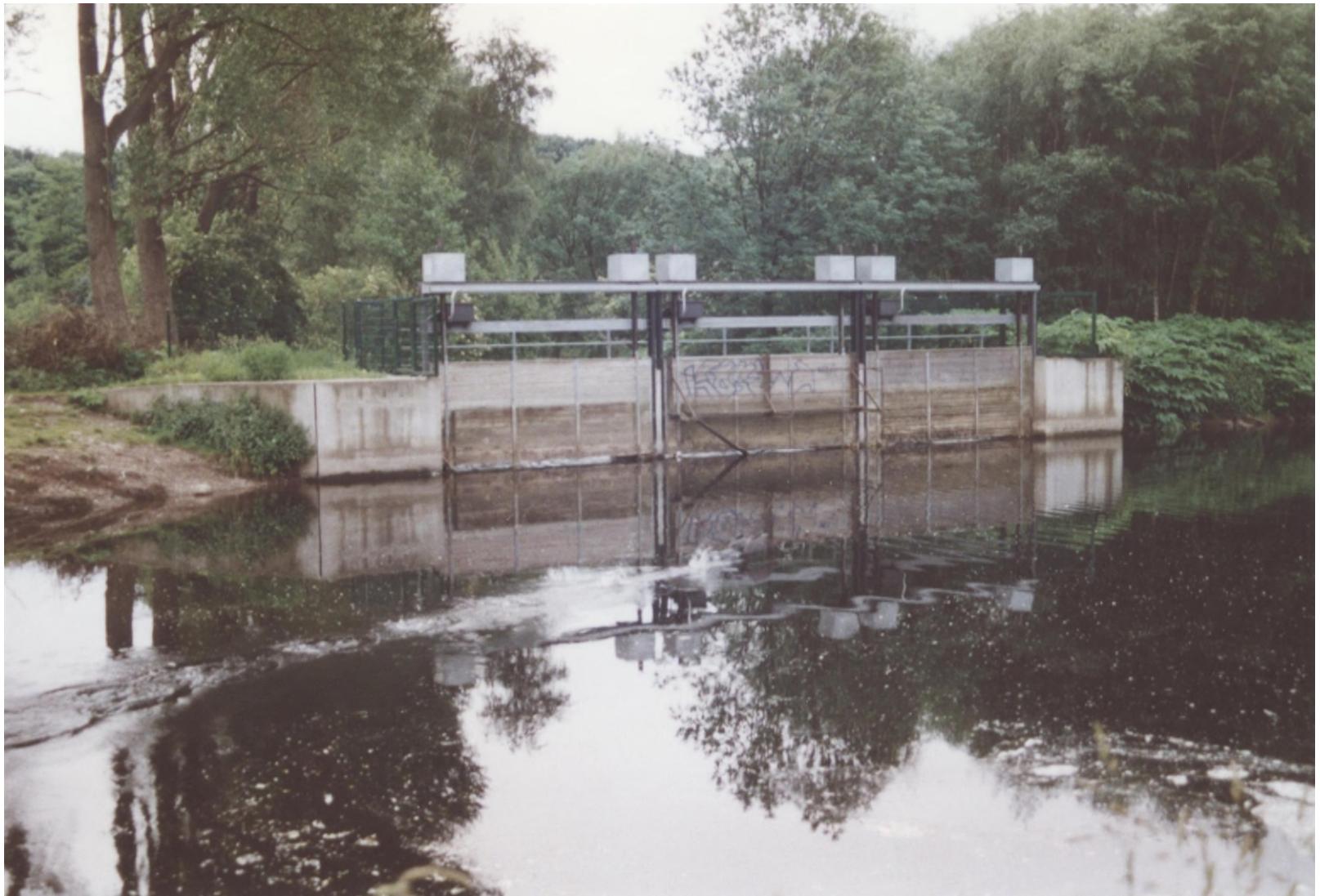
Abb. 97: Das neue Einlaufwehr zum Mühlengraben der Reuschenberger Mühle am 09.06.2002
