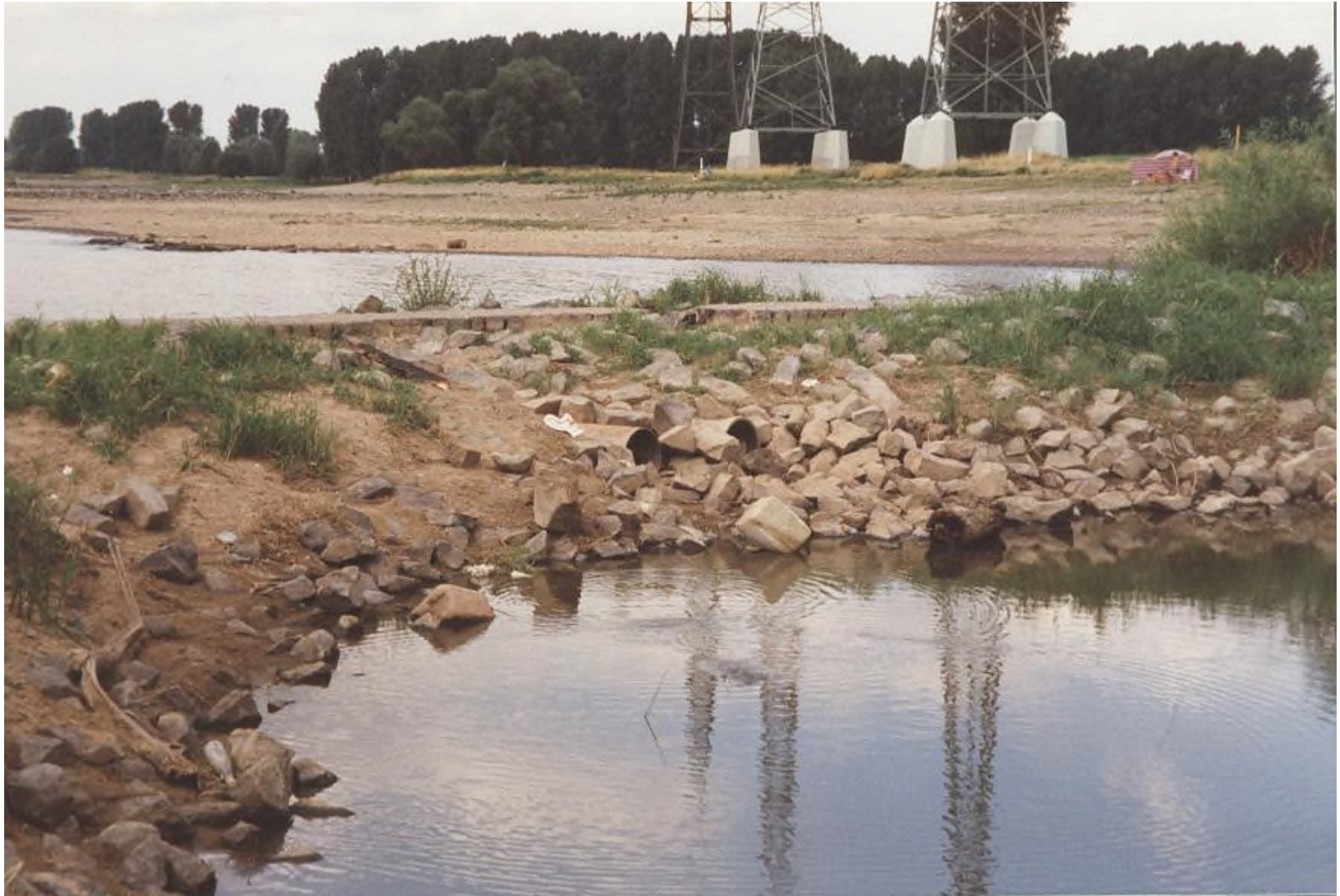
Abb. 109: Die alte Wuppermündung wurde zum Rhein hin durch einen Steinwall getrennt. Etwa 1 m über der Sohle waren zwei Verbindungsrohre angeordnet, sodass die Fische bei Niedrigwasser nicht vollständig in den Rhein abwandern konnten. 01.08.1994
