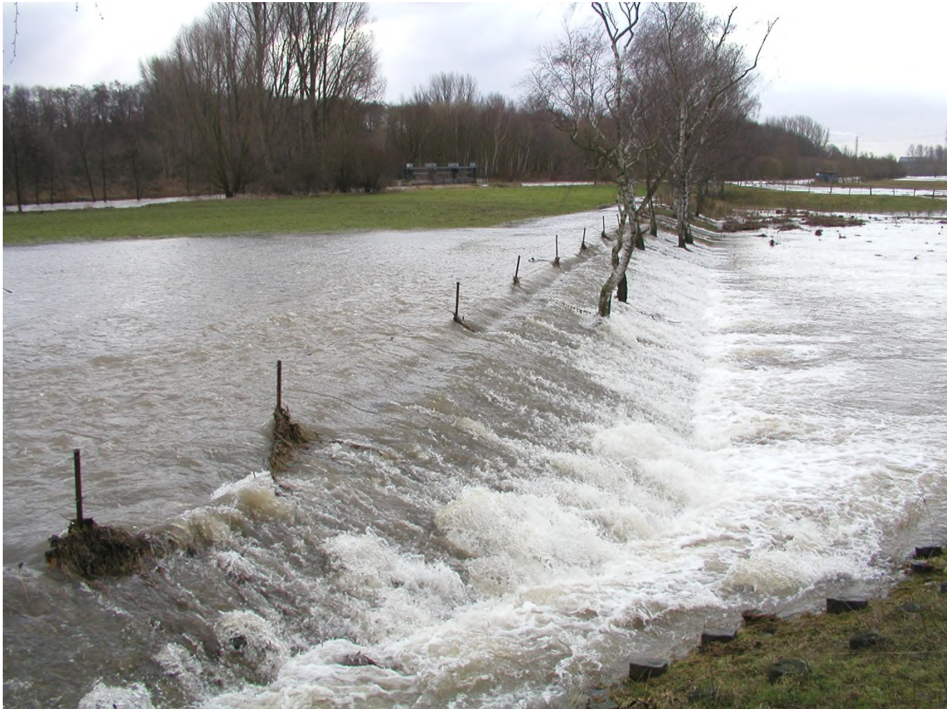
Abb. 58: Überlaufkante in den Hochwasserflutgraben oberhalb des Reuschenberger Wehres am 21.01.2005 Foto: Günter Schmidt
