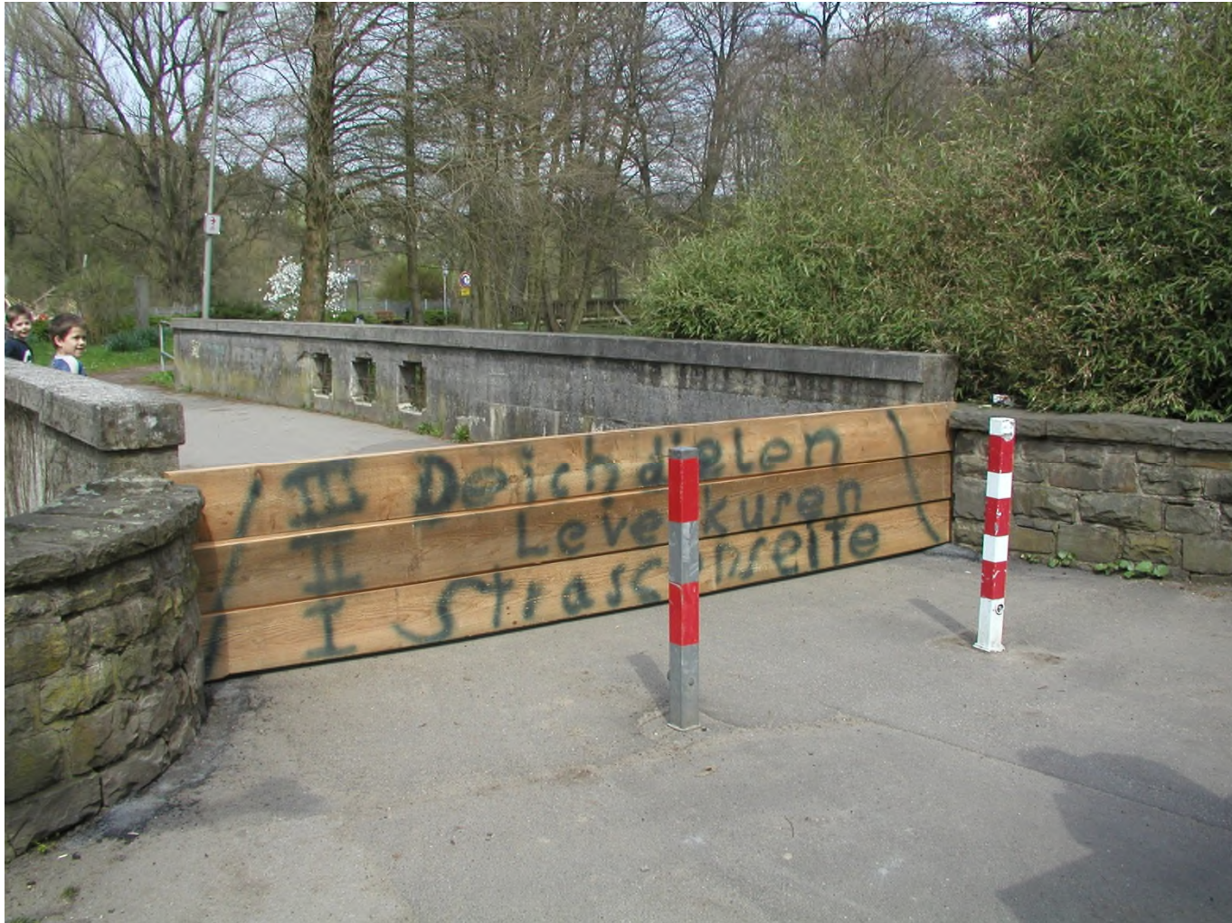
Abb. 64: Das Deichtor an der Rehbockanlage wird durch Holzdielen geschlossen, die auf dem Bauhof der Technischen Betriebe Leverkusen gelagert werden.
