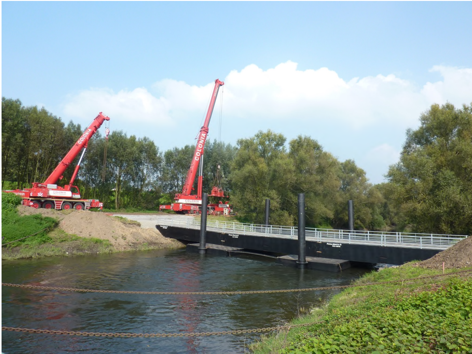
Abb. 128: Das Bild zeigt die temporäre Wupperbrücke nach Ihrer Verlegung. Im Vordergrund sind zwei Ankerketten der vorhandenen Pontonbrücke zu erkennen, 08.09.14
