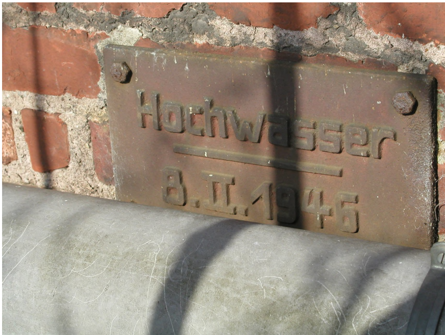
Abb. 27: Hochwassermarke mit Datum 08.02.1946 an einem Gebäude der SKF_Sealing Solutions GmbH (ehemals Goetze), 18.03.2013
