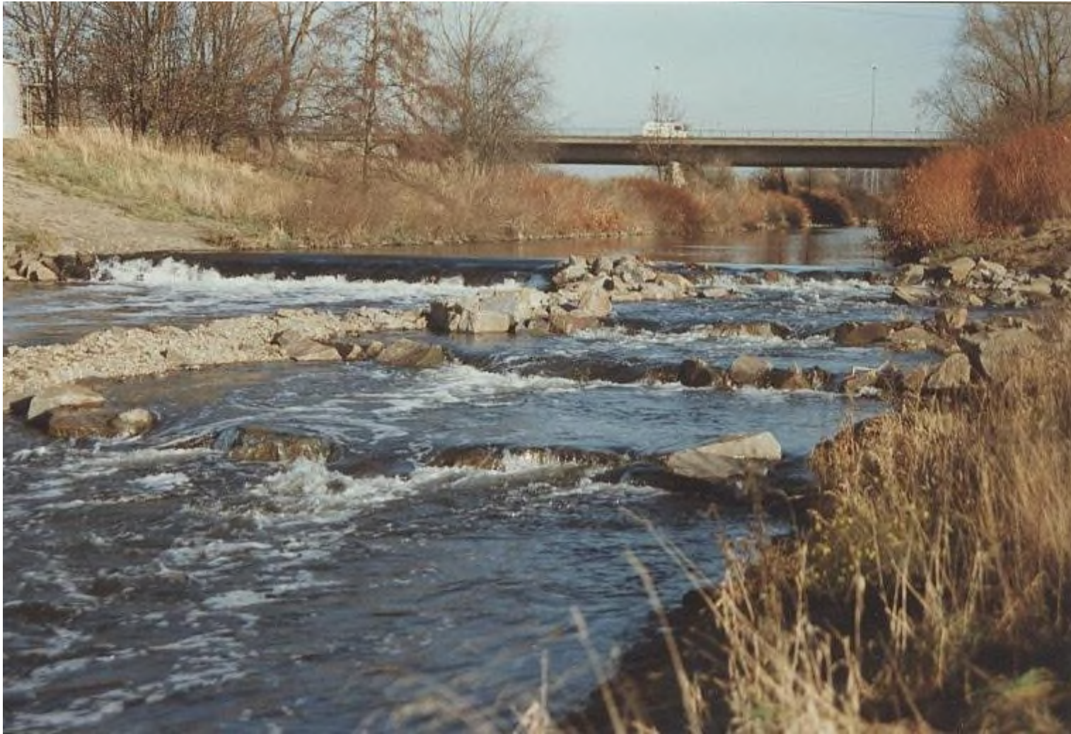
Abb. 51: 1997 wurde dem Tonnenwehr in der Wupper oberhalb der Dhünnmündung auf der linken Flusseite eine Fischrampe vorgeschaltet. 19.11.1997
