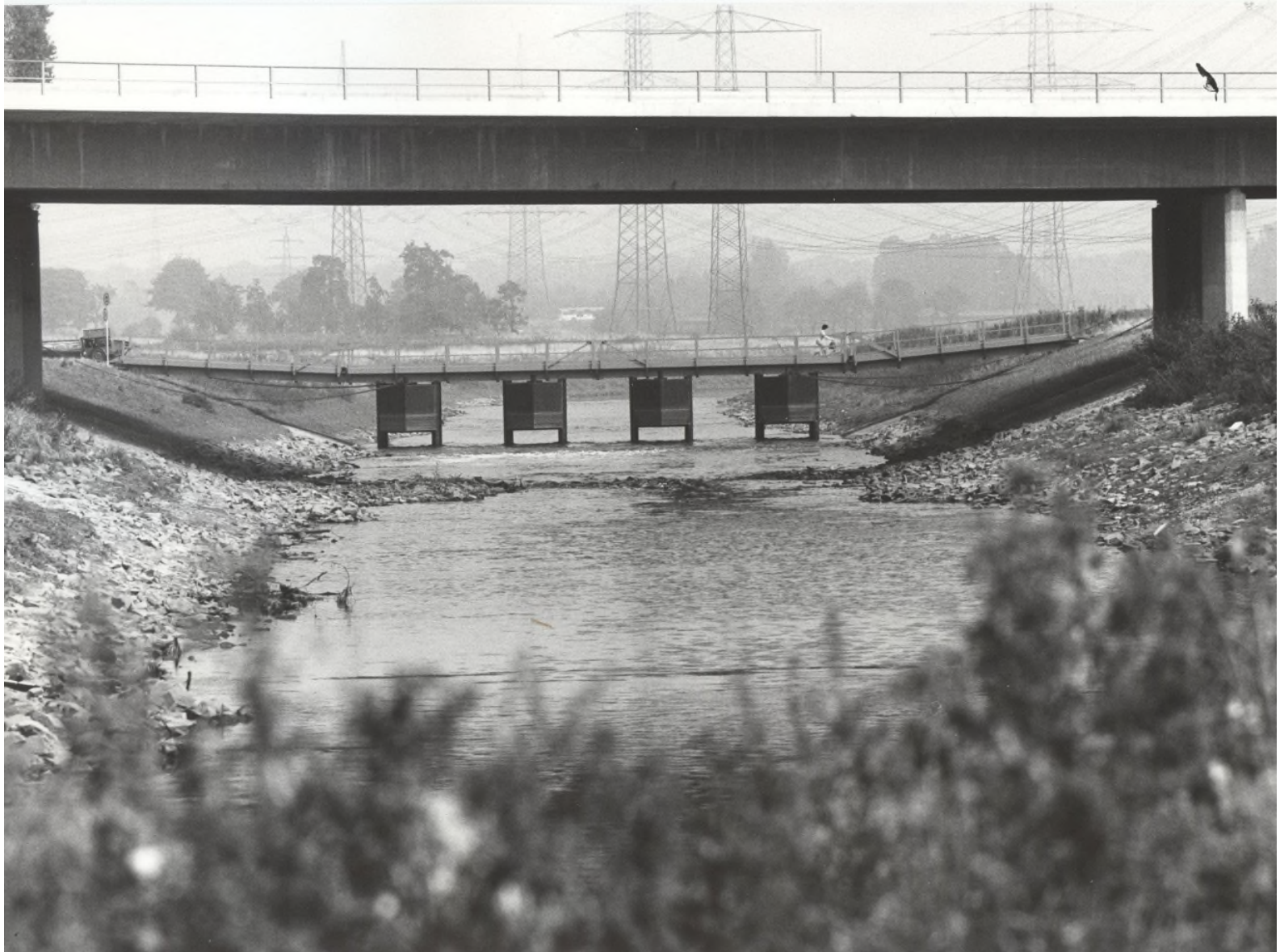
Abb. 33: Bis zum Umbau 1992 besaß die Pontonbrücke über die Wupper in Rheindorf vier statt der heutigen drei Schwimmkörper Foto: Stadtarchiv Leverkusen
