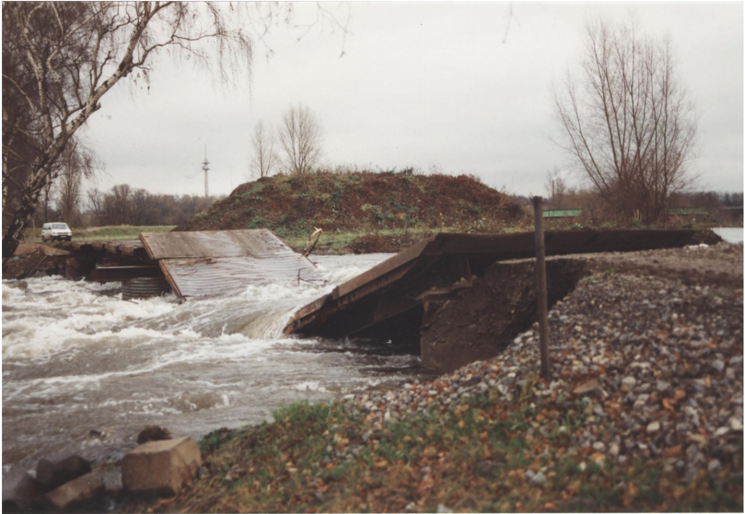
Abb. 91: Bei Hochwasser brach die Behelfsbrücke zweimal zusammen, wie hier nach dem Hochwasser vom Januar 1999 (Höchststand am Pegel Opladen: 216 cm am 12.01.1999).
