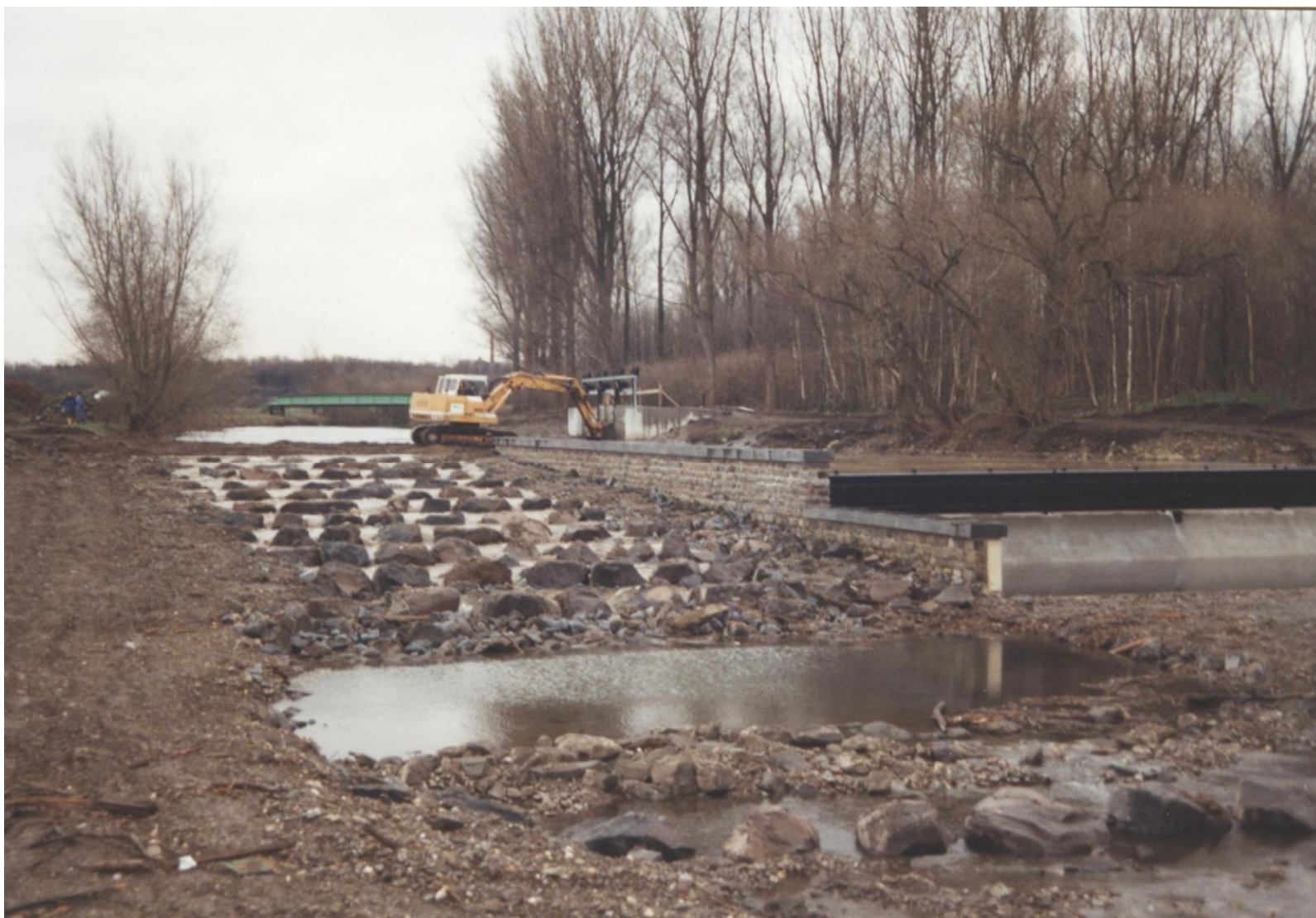
Abb. 92: Am 17.12.1999 wurde der provisorischer Damm oberhalb des Reuschenberger Wehres geöffnet und die Fischrampe in Betrieb genommen.
