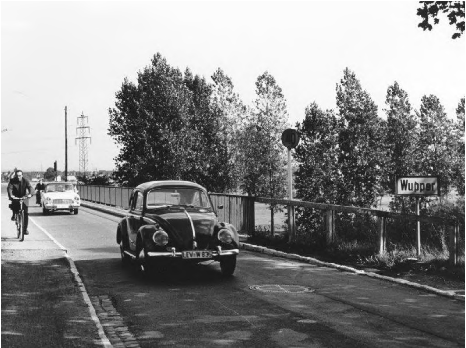
Abb. 136 Die 1911 erbaute Rheindorfer Wupperbrücke war schon für normale Kraftfahrzeuge nicht gleichzeitig in zwei Richtungen befahrbar. Der Gegenverkehr musste warten bis die Brücke frei war. 20.08.1964
