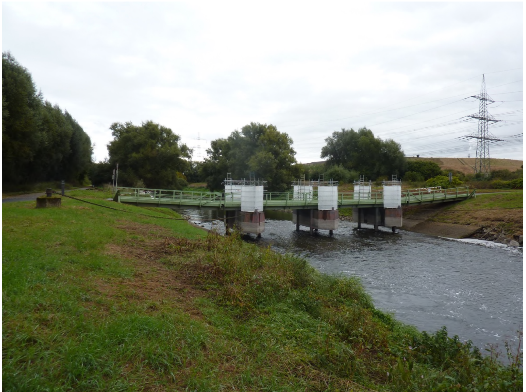
Abb. 144: Im Oktober 2016 führte die Bayer Real Estate kleinere Reparaturarbeiten an der Pontonbrücke durch. Dazu musste auch in die Pontons eingestiegen werden. Am 12.10.16 führte die Wupper Niedrigwasser. Foto: Günter Schmidt
