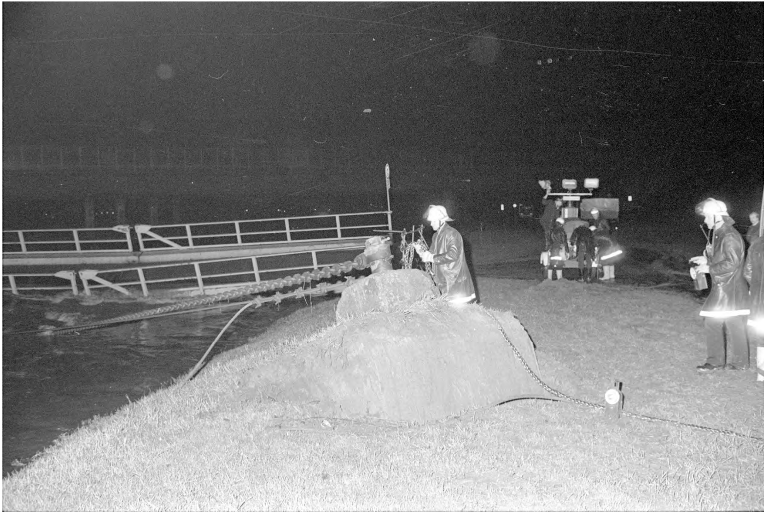
Abb. 32: Ein kleineres Hochwasser bescherte am 23.03.1987 der Bayer-Werksfeuerwehr einen Nachteinsatz. Sie musste zwei gelockerte Betonanker mit Drahtseilen sichern, um ein abdriften der Potonbrücke in den Rhein zu verhindern.
