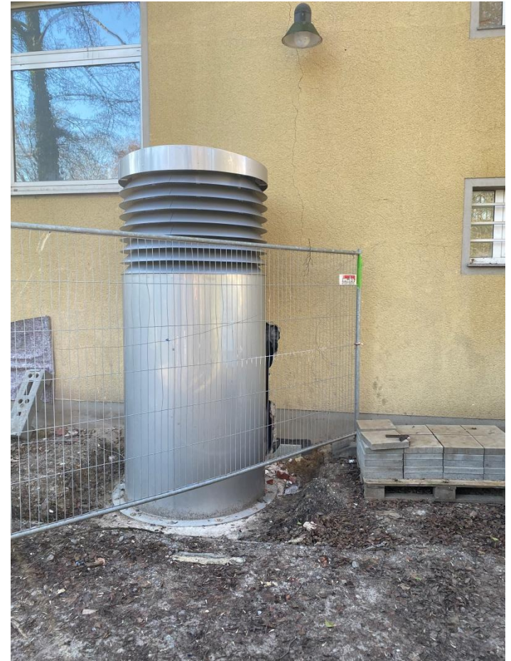
Aufbau Aussenluftansaugturm
